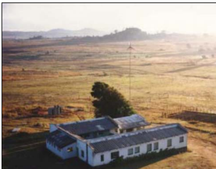
Foto 2.1. Utilización de un aerogenerador de baja potencia en una casa rural en Zimbabwe. (Hugh Piggott) [8]
