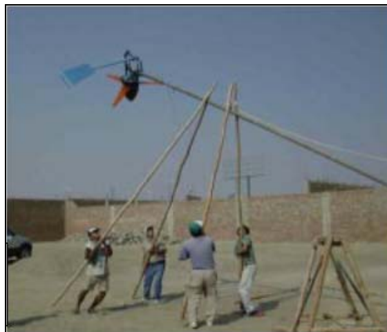
Foto 3.3. Levantado de una torre con palos y cuerdas en Perú. [8]
