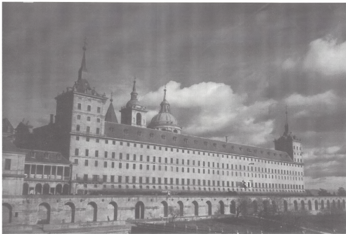
1. Vista de la fachada Sur del Monasterio de El Escorial
