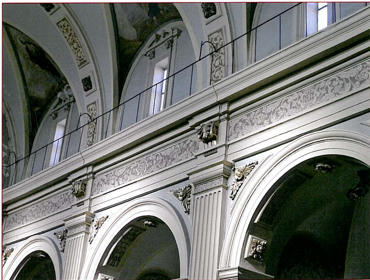
Fig. 10. Detalle ménsulas foliadas y triglifo del friso. Foto Luis Arciniega
