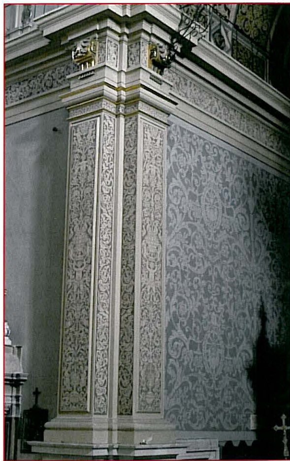
Fig. 23. Pilares torales con esgrafiados. Foto Luis Arciniega
