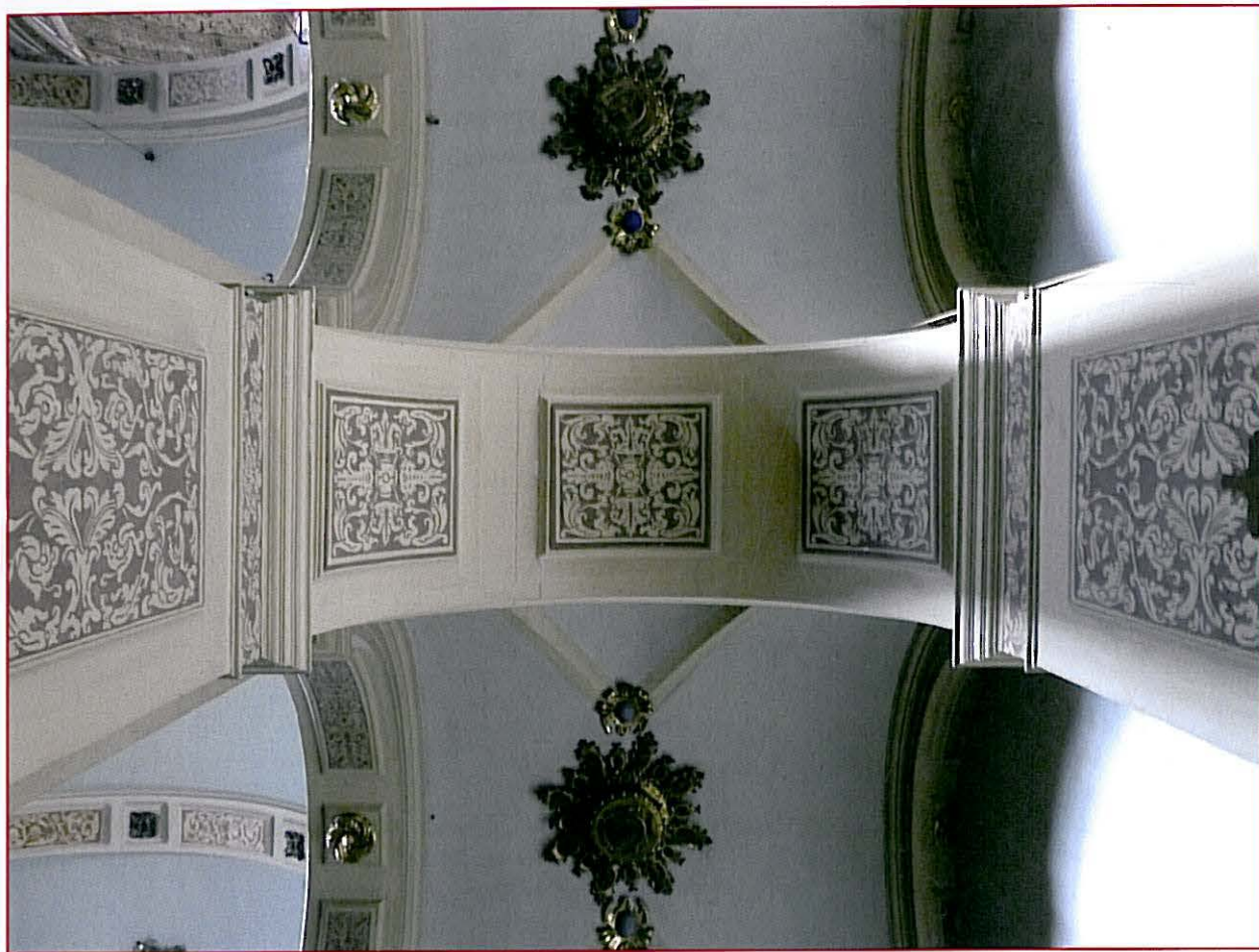
Fig. 9. Diferente dirección de las bóvedas de cañón con lunetos en nave principal y espacios laterales. Foto Luis Arciniega
