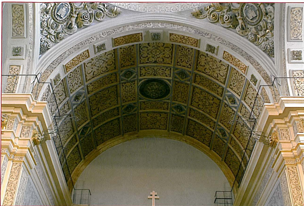
Fig. 25. Presbiterio con bóveda de cañón seguido con formas geométricas y esgrafiados. Foto Vicent Bori
