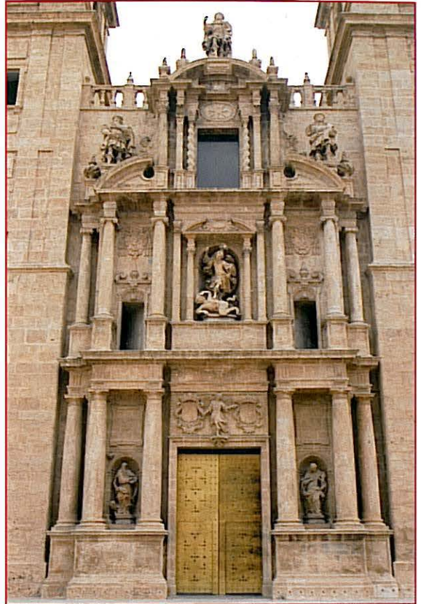
Fig. 18. Vista general de la fachada del monasterio de San Miguel de los Reyes, afueras de Valencia. Foto Luis Arciniega
