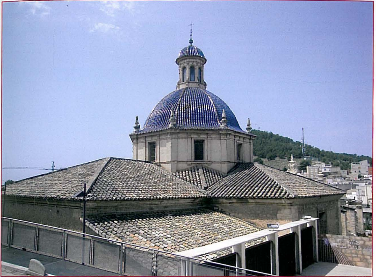
Fig. 3. Vista de la cabecera desde la colina de la Sangre, obsérvese el pronunciado desnivel en el que se encuentra la iglesia de la Asunción. Foto Luis Arciniega
