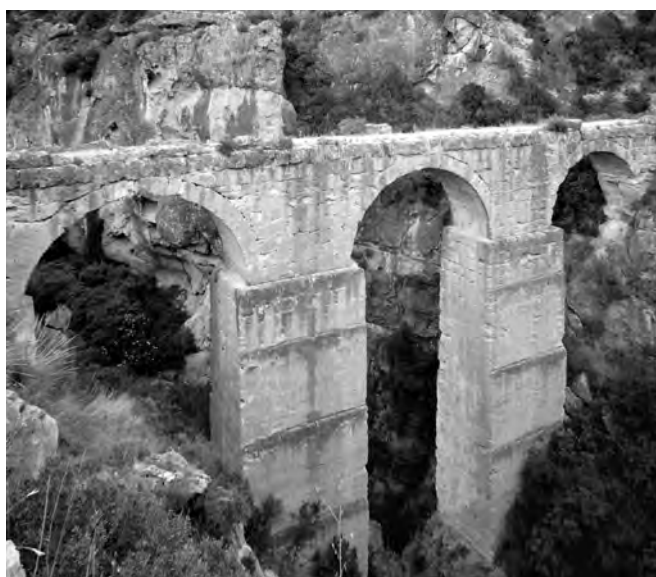
Fig. 14. Acueducto romano de Peña Cortada.
