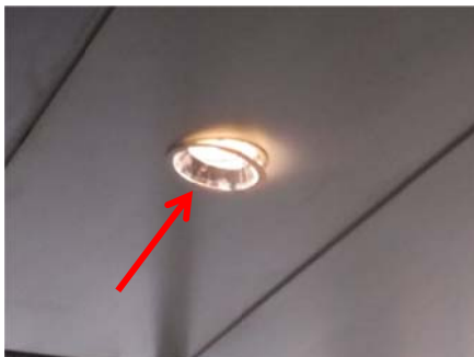
Despreniment de focus al costat de la porta del CAL
