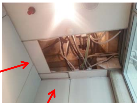
Techo del lavabo biblioteca. Planchas desajustadas
