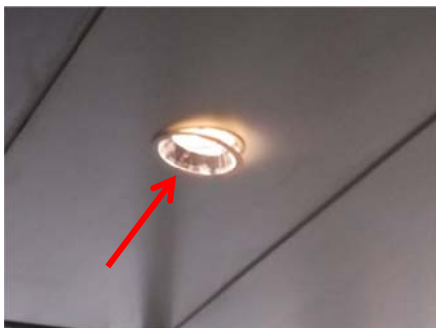
Desprendimiento foco de la Puerta del CAL, Burjassot
