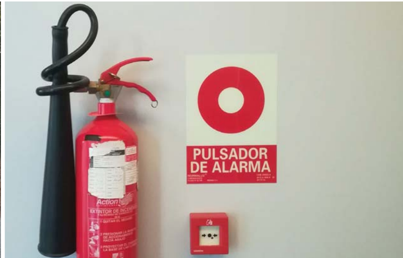
Renovaci n del sistema de contraincendios
