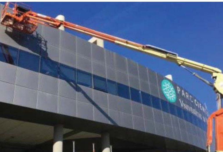
Reparaci n de las cubiertas y fachadas de los edificios 1 y 3
