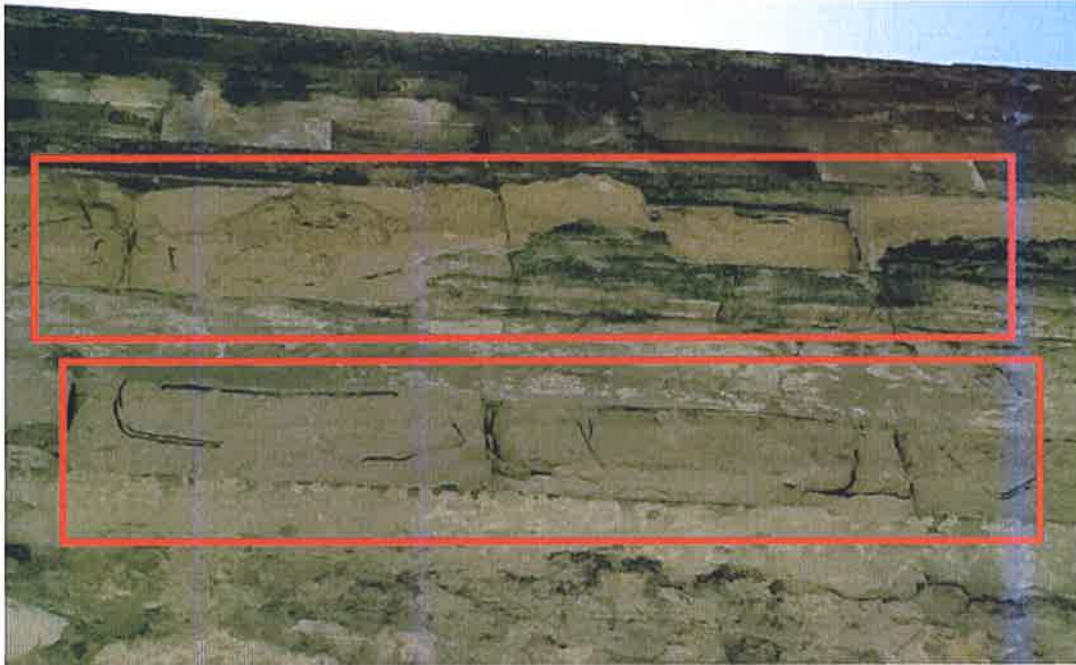
Figura 25. Primer plano de cornisa doble en dos hileras de piezas. Se aprecia perfectamente las partes de las piezas voladas prefabricadas, que han quedado empotradas en el muro, con el alambre en forma rectangular visto.
