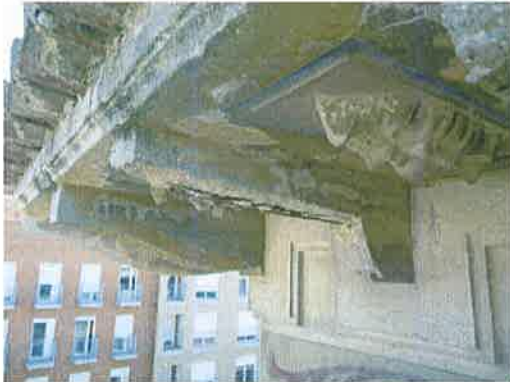
Figura 16. Apenas se toca la pieza se desprende parte de la ménsula (izquierda).
