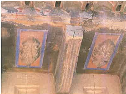
Figuras 32 y 33. Izquierda, cornisa lado sur torre norte. Desconche en mortero armado de pieza tablero que apoya en ménsula "pinchada" armada con alambre, y la misma con fractura desde su testa hasta su inicio en el empotramiento. Derecha torre sur, lado norte, ménsulas con roturas longitudinales por expansión del metal oxidado.
