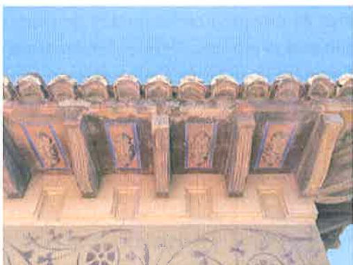
Figuras 32 y 33. Izquierda, cornisa lado sur torre norte. Desconche en mortero armado de pieza tablero que apoya en ménsula "pinchada" armada con alambre, y la misma con fractura desde su testa hasta su inicio en el empotramiento. Derecha torre sur, lado norte, ménsulas con roturas longitudinales por expansión del metal oxidado.
