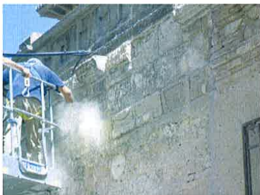
Figuras 11 y 12. Trabajos de saneado y retirada de piezas o material inestable manualmente.
