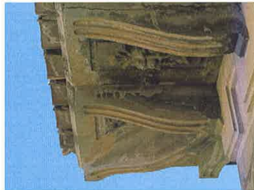
Figuras 32 y 33. Izquierda, cornisa lado sur torre norte. Desconche en mortero armado de pieza tablero que apoya en ménsula "pinchada" armada con alambre, y la misma con fractura desde su testa hasta su inicio en el empotramiento. Derecha torre sur, lado norte, ménsulas con roturas longitudinales por expansión del metal oxidado.
