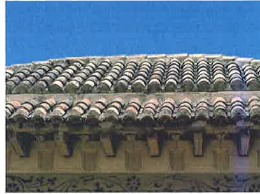
Figuras 30 y 31. Izquierda, cornisas ornamentales de las torres laterales de la fachada principal, desde la terraza plana. Torre norte. Derecha, detalle de alero, y en medio del faldón canalón oculto.
