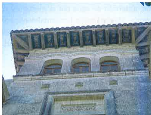
Figuras 32 y 33. Izquierda, cornisa lado sur torre norte. Desconche en mortero armado de pieza tablero que apoya en ménsula "pinchada" armada con alambre, y la misma con fractura desde su testa hasta su inicio en el empotramiento. Derecha torre sur, lado norte, ménsulas con roturas longitudinales por expansión del metal oxidado.
