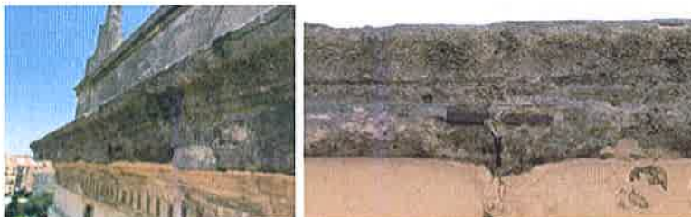
Figuras 45 y 46. Cornisa cuerpo central, lateral norte y detalle. Se observan las llaves metálicas.
