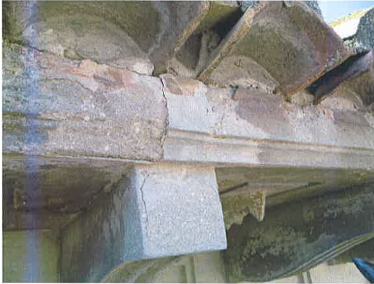
Figuras 39 y 40. Arriba. Torre sur, lado norte.
