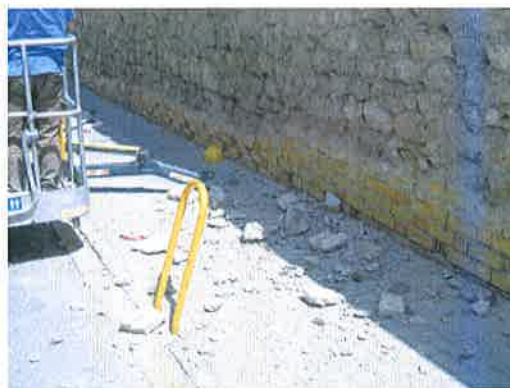
Figuras 13 y 14. Restos de escombros de cornisa en suelo tras saneado manual en Llombo.
