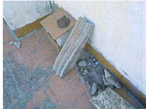
Figura 16. Apenas se toca la pieza se desprende parte de la ménsula (izquierda).
