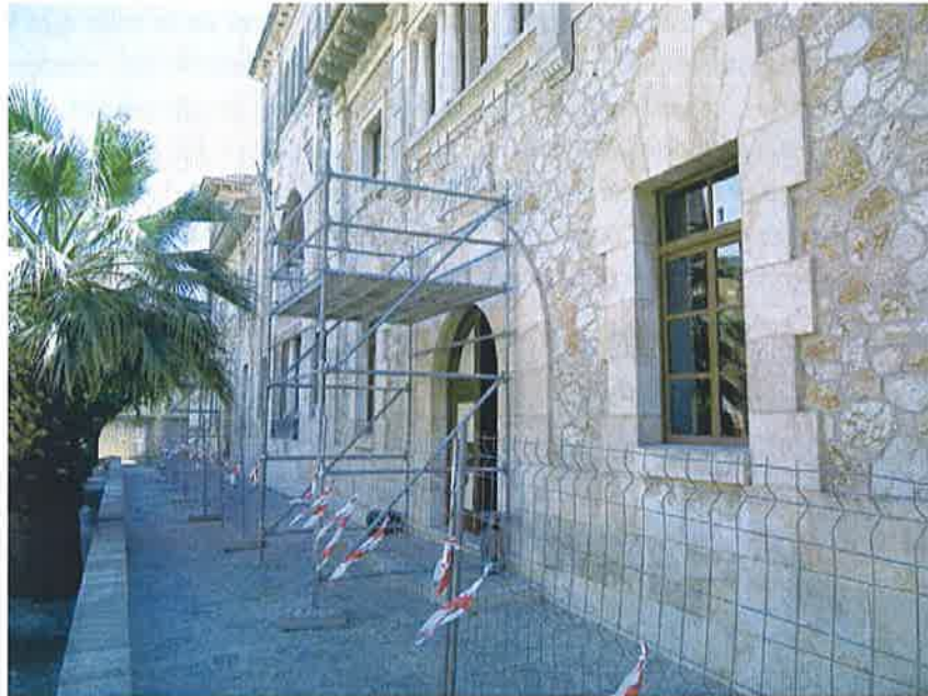
Figura 5. Protección con valla y marquesina en fachada principal.
