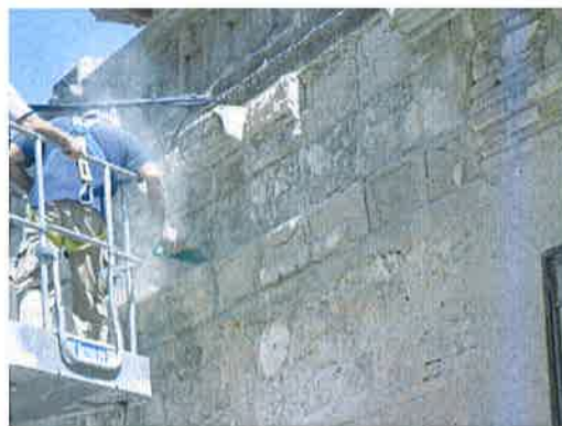
Figuras 11 y 12. Trabajos de saneado y retirada de piezas o material inestable manualmente.
