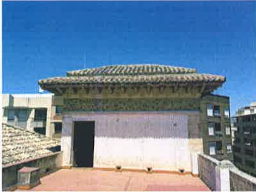
Figuras 30 y 31. Izquierda, cornisas ornamentales de las torres laterales de la fachada principal, desde la terraza plana. Torre norte. Derecha, detalle de alero, y en medio del faldón canalón oculto.
