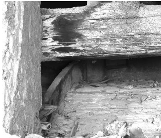
Cerchas curvadas de carpintería con cañizo (Foto: J. Bérchez, 2005).
