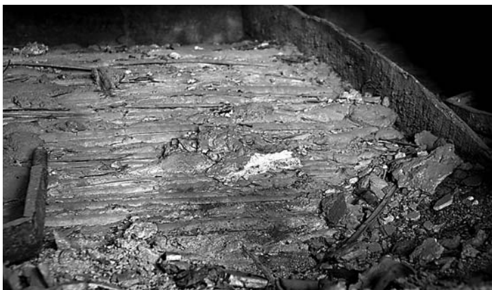
Cerchas curvadas de carpintería con cañizo (Foto: J. Bérchez, 2005).
