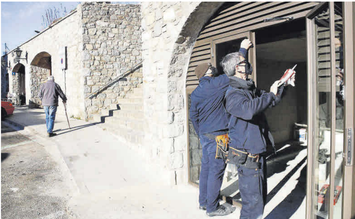
Instalación de un nuevo cajero automático en Llanars (Ripollès).
