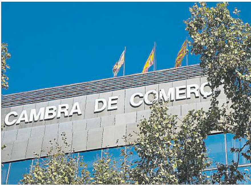
Fachada de la Cambra de Comerç de Barcelona
