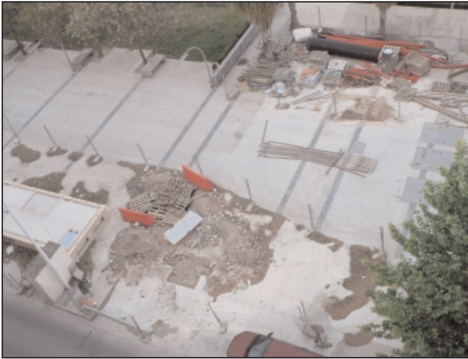
Obras de las estaciones de bombeo, el cuento de nunca acabar.
