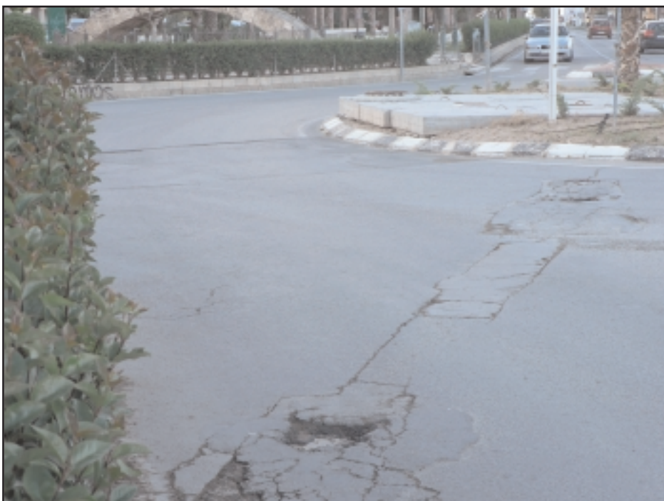
Calzadas por reparar.
