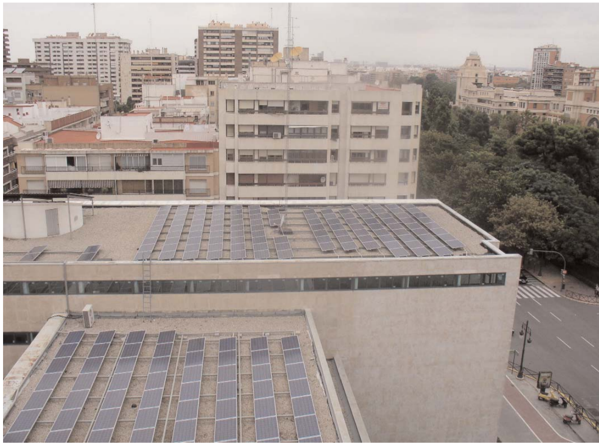
Una imatge dels panells instal·lats sobre la Facultat de Geografia i Història.
