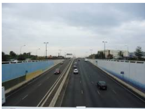
Túnel av. de Catalunya per davall de la rotonda.
