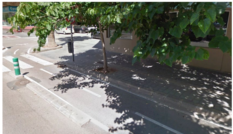
En alguns punts la vorera s'estreny a causa de la presència d'alguns edificis que sobreixen. La vorera no conforma una línia recta.
