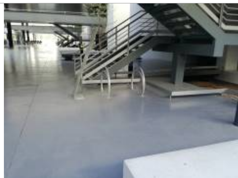
Aparcament núm. 4. Edifici 1
