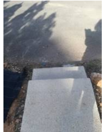
Escalons en l'accés a l'aparcament.
