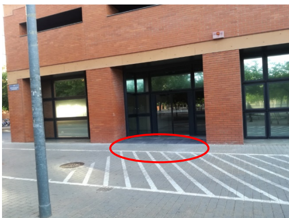
Escalons en algunes portes, que es redueixen fins a arribar al nivell de la vorera
