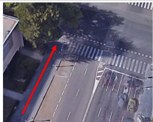
Vorera més ampla en l'av. Suècia, sense carril bici. Pas de vianants rebaixat per a travessar l'avinguda.
