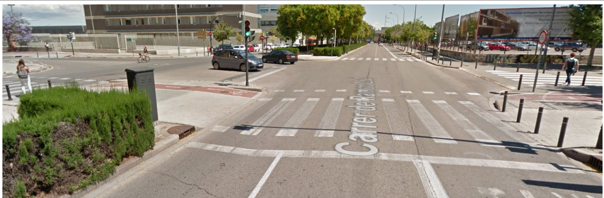
Rastells rebaixats en voreres i illeta en l'encreuament amb el c. Ramon Llull.
