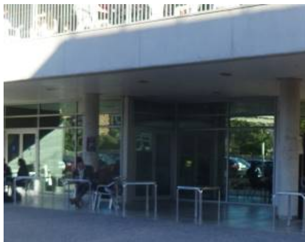
Aparcament núm. 3. Edifici 14
