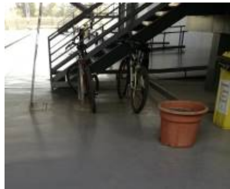
Aparcament núm. 2. Edifici 3
