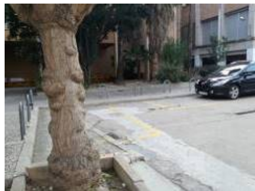
Vorera protegida amb bol·lards en "U" invertida
