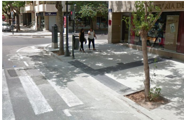
Pas de vianants prop de l'encreuament amb el c. Dr. Moliner, amb rebaix en la vorera i paviment senyalitzador.
