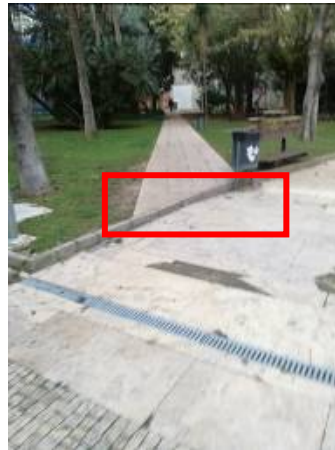
Rastell que dificulta el pas a PMR
