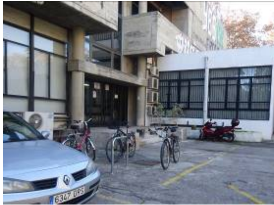
Aparcament núm. 1. Pàrquing intern
