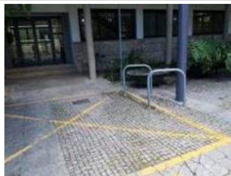
Aparcament núm. 4. Entrada edifici 3 (1)
