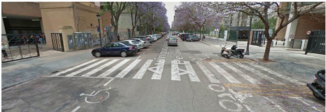
Pas de vianants amb rebaixos i paviment senyalitzador.
