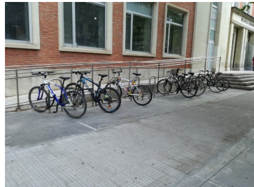
Biblioteca d'Humanitats: accés mitjançant escalons o rampa amb passamà doble
