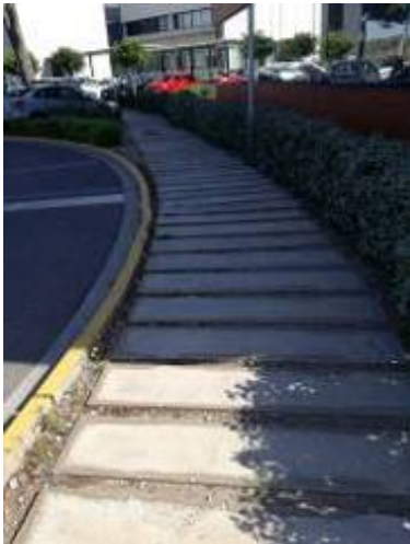
Camí amb paviment irregular amb buits que dificulten la mobilitat de PMR
