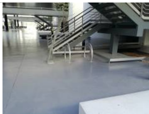
Aparcament núm. 4. Edifici 1
