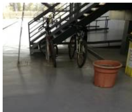
Aparcament núm. 2. Edifici 3
