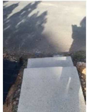
Escalons en l'accés a l'aparcament.
