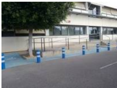
Ed. 4 (Institut de Robòtica): escala i rampa
