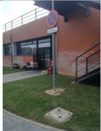
Senyal vertical de zona de càrrega i descàrrega
