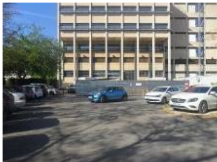
Cotxes sobre vorera i envaint el vial de circulació intern
