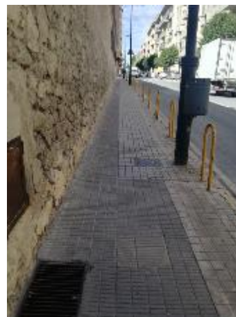
Vorera de l'av. del Llombo, protegida amb bol·lards en "U" invertida.
