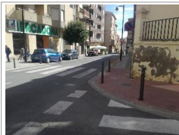
Connexió de la vorera amb els passos per a vianants, encreuament c. Echegaray - av. del Llombo, amb rebaix, paviment diferencial per a PMR i protecció amb bol·lards.
