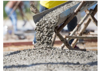
Formigó abans d'endurir
