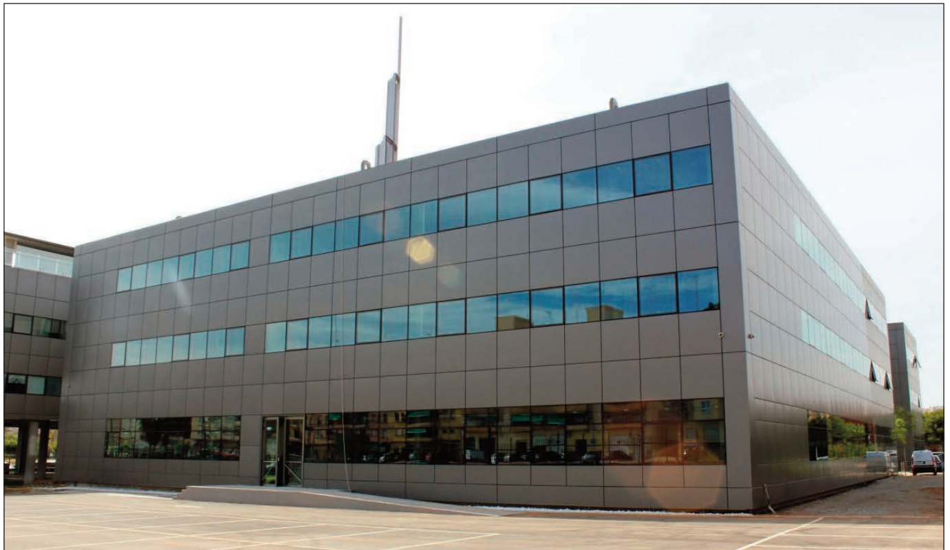
Ampliación del Edificio 3 (Centro Universitario Empresarial-CUE) del PCUV
