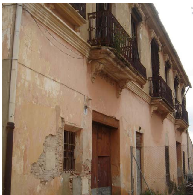
Imatge 9: Vista parcial de la façana principal de l'alqueria de Rulla, en Vistabella, reformada en època contemporània
