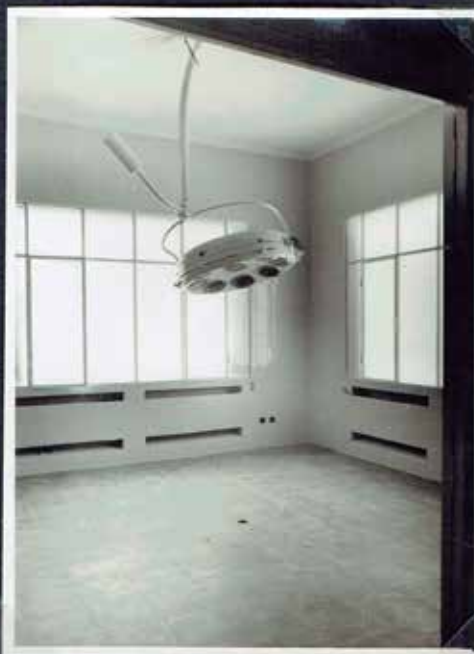
DETALLE DE QUIRÓFANO.
