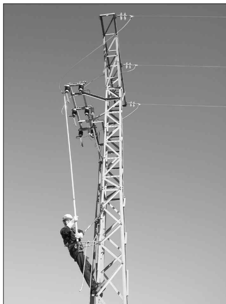
Un equipo de técnicos se encarga periódicamente de las labores de mantenimiento de la red.
