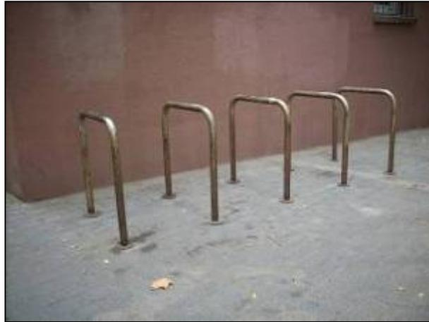
Figura 60: Aparcabicis con soportes oxidados (BACC)
