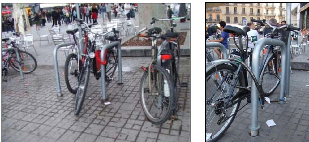
Figura 68: Mala fijación de los soportes (BACC)
