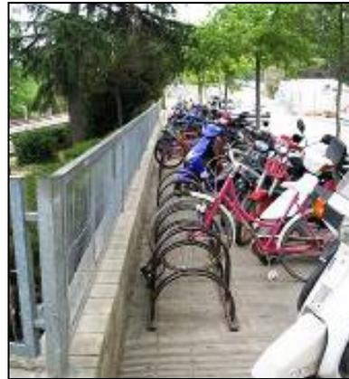
Figura 14: Aparcabicis con soportes de rueda horizontales (BACC)
