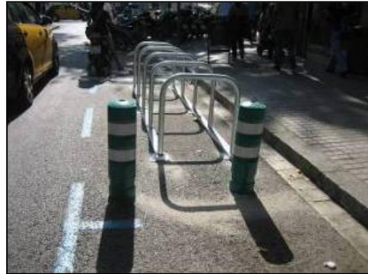
Figura 78: Aparcabicis en calzada con bolardos de protección (BACC)
