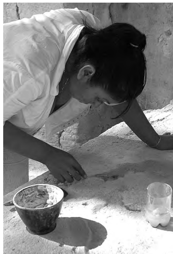
Aplicación de refuerzos perimetrales con mortero natural
