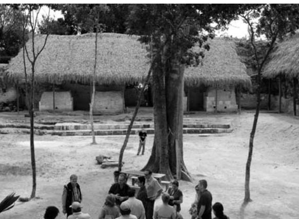
Vista del patio interior de la acrópolis de La Blanca (fotografía Ch. Heck)
