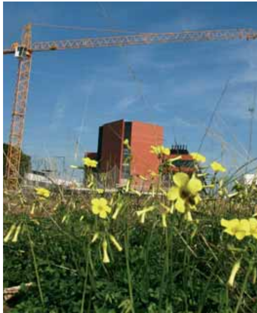
Obres al Parc Científic de la Universitat. FOTO: M. LORENZO
