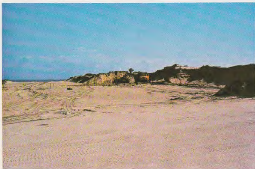
Fig. 34. Trabajos de desmonte de la duna litoral. (Foto Defauce).
