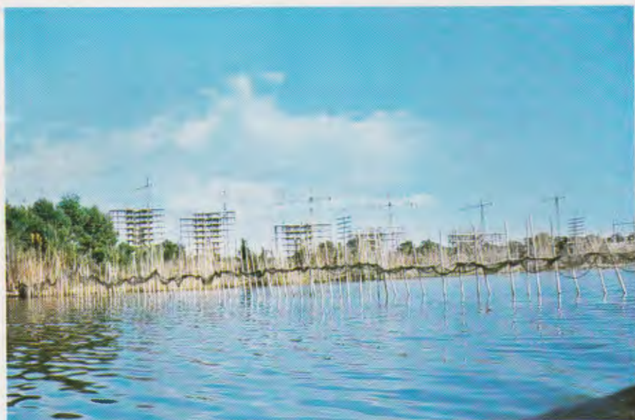
Fig. 33. Torres en construcción junto al canal de Puchol. (Foto Montoya).
