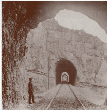
Túnel de Siete Aguas. Buñol. Biblioteca Valenciana. Túnel de Siete Aguas. Buñol. Biblioteca Valenciana.
