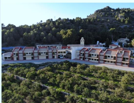
Centro de acogida San Francisco de Asís
