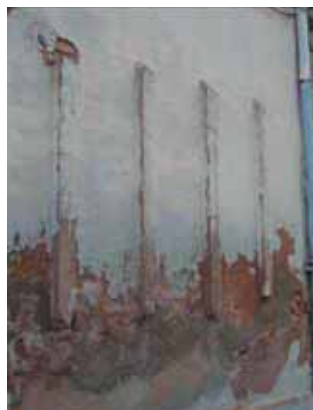
Il·lustració 108. Detall de paret al carrer Balmes (Païporta) (Font: L'autor, 2008)
