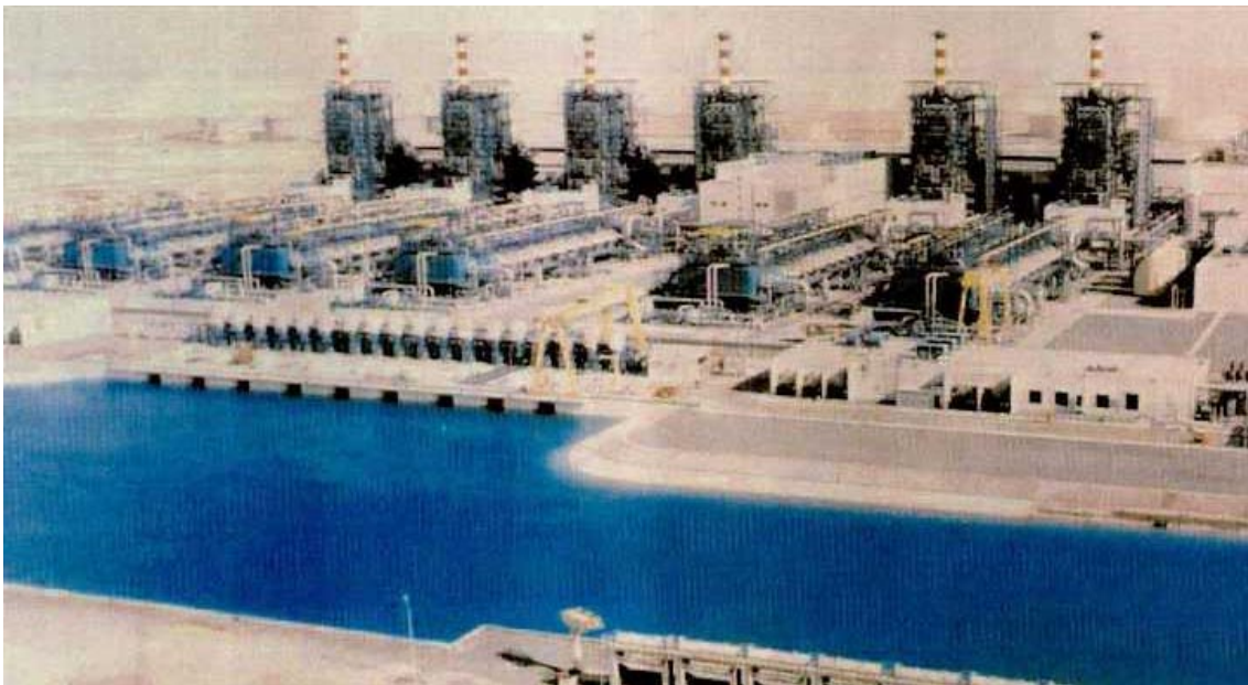
Figura a1.6. Fotografía de la planta Al Taweelah B (Abu Dhabi, Emiratos Árabes Unidos). Fuente: Italimpianti (1996).
