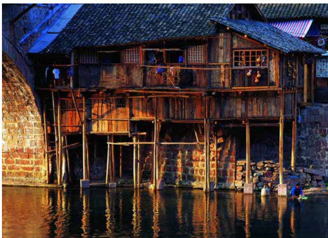
重庆临江吊脚楼。Las casas en saledizo sobre el río.
