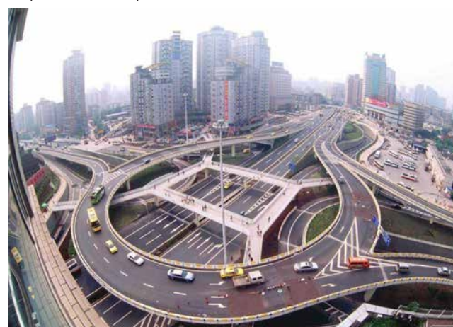
纵横交错的立体交通网络。 Nudo de autopistas a diversas alturas entrelazadas con pasos elevados de peatones.
