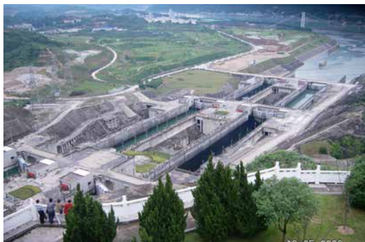
船闸能把排水量达 12000 吨的船只托高 150 米。Las esclusas pueden elevar barcos de hasta 12.000 toneladas de desplazamiento a 150 metros de altura.
