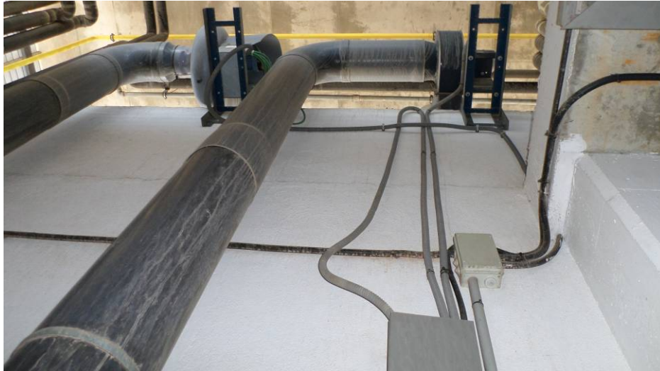
Conducciones eléctricas afectadas por la humedad de los patinillos.
