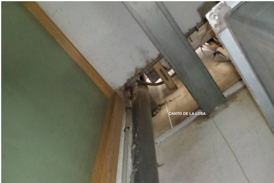
Desagüe del canalón, por encima de la losa de cubierta
