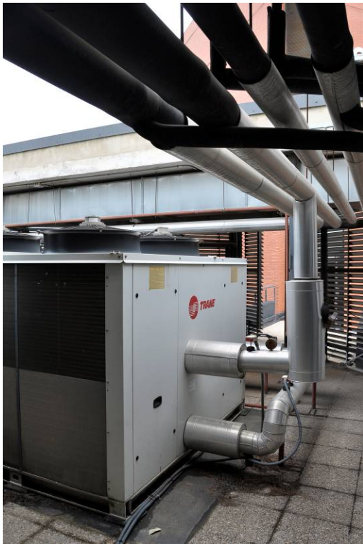
Enfriadora del edificio de cabecera, con el hueco de ventilación. Al fondo, acceso al recinto, único punto en el que el pavimento interior desagua libremente.
