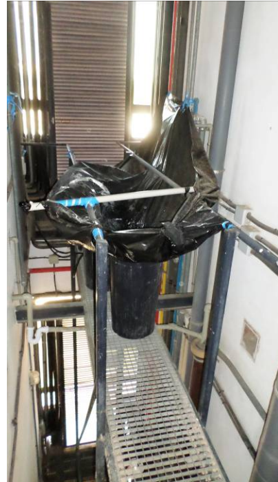
Señales de goteo del agua en el interior de uno de los patinillos, y medidas provisionales adoptadas por los usuarios y el servicio de mantenimiento.
