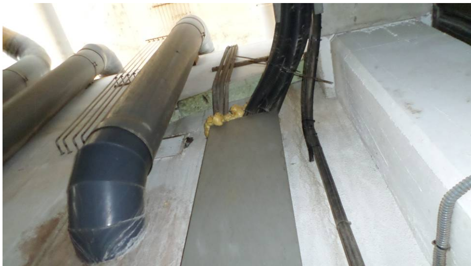
Sellado de una bandeja eléctrica para tratar de evitar la entrada de agua
