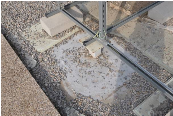
Apoyo metálico para las placas solares, perforando la tela impermeable. La reparación de la impermeabilización ha fisurado.
