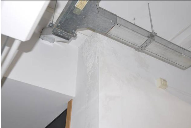
Humedad en la pared de uno de los patinillos, vista por el lado de los laboratorios.
