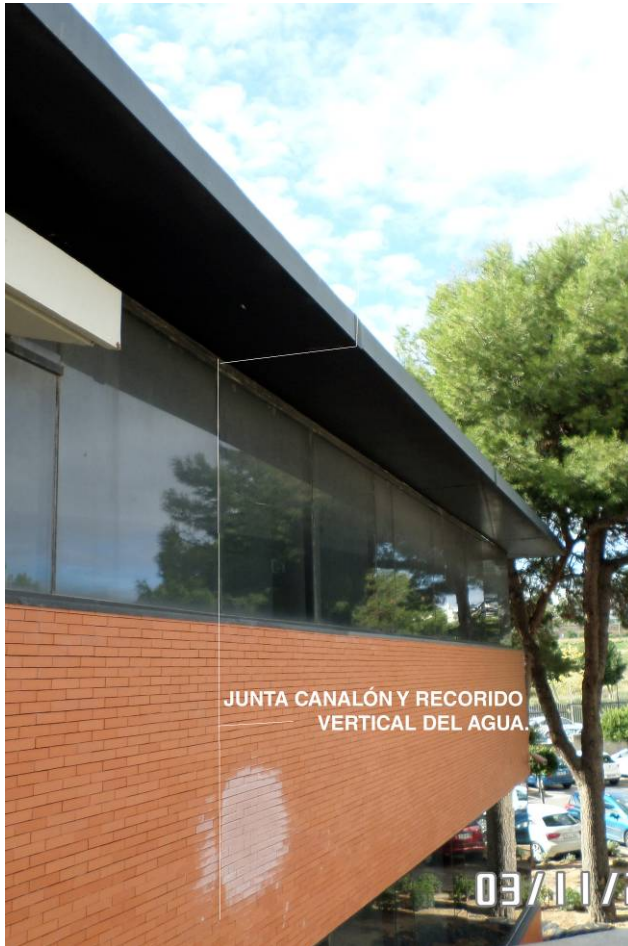
Eflorescencias en el ladrillo cara vista. Entrada de agua proveniente de la junta abierta del canalón.
