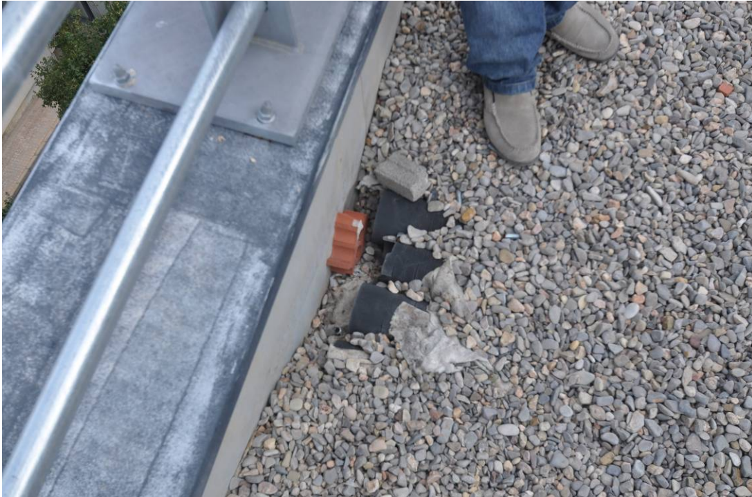
Final de las líneas de drenaje en la cubierta del ICMol.
