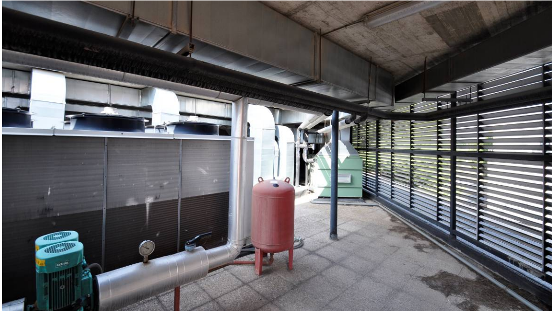
Instalaciones en la cubierta del edificio de cabecera. Recinto por debajo de la impermeabilización exterior, con una única salida de agua, a nivel, en el acceso por la pasarela que comunica con el núcleo de comunicaciones verticales.
