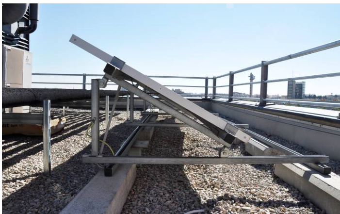
Estructura de soporte de las placas solares sobre la cubierta, mediante piezas prefabricadas de hormigón (bordillos).
