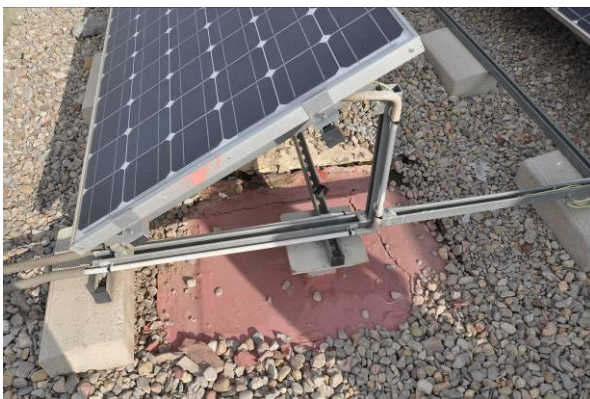
Reparación de la impermeabilización con un mortero y/o pintura armada, sin éxito (fisuras de rotura).
