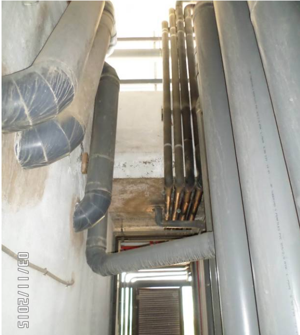
Interior de uno de los patinillos un día después de lluvias. Se observan los regueros que deja el agua sucia por los tubos de ventilaciones.
