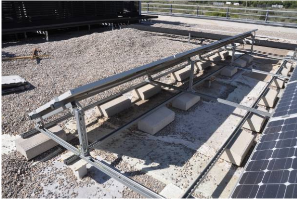
Apoyo de las placas sobre bordillos de hormigón y, puntualmente, sobre soportes metálicos.
