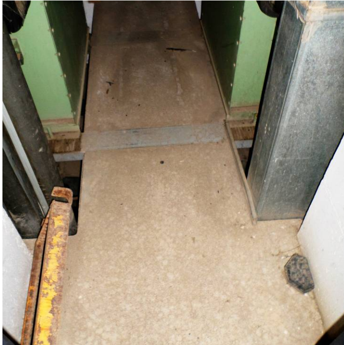
Señales de goteo del agua en el interior de uno de los patinillos, y medidas provisionales adoptadas por los usuarios y el servicio de mantenimiento.
