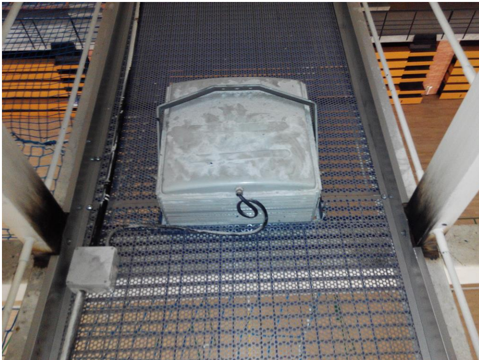
Detalle de chapa perforada colocada sobre tramex.
