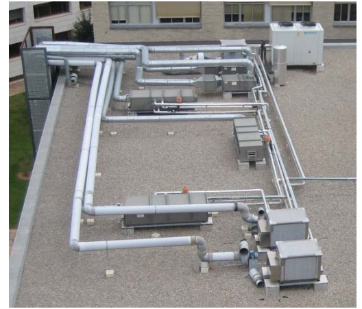
Sistema Fachada Noroeste
