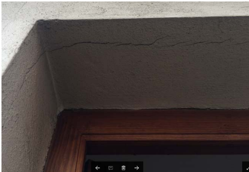
Arriba: fisuras en jambas y dinteles de fachada recayente a calle Bolsería.
