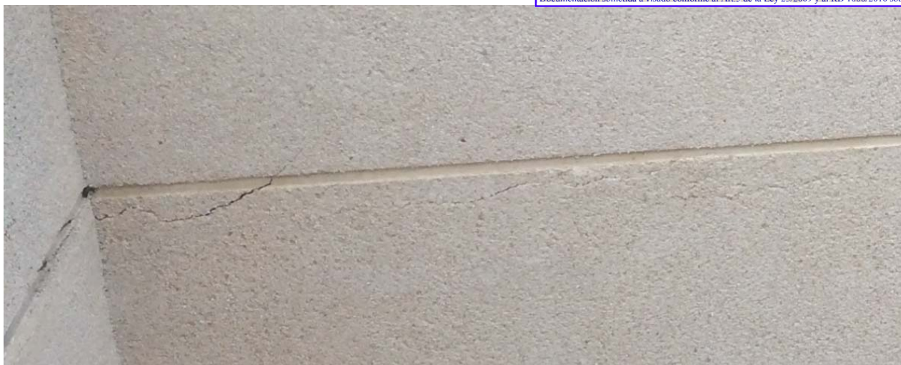
Arriba: grieta por empuje de cubierta en principio estabilizada o estacional. Arriba enmarcada en rojo su ubicación:
