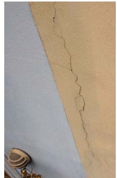
Arriba: fisuras en jambas y dinteles de fachada recayente a calle Bolsería.
