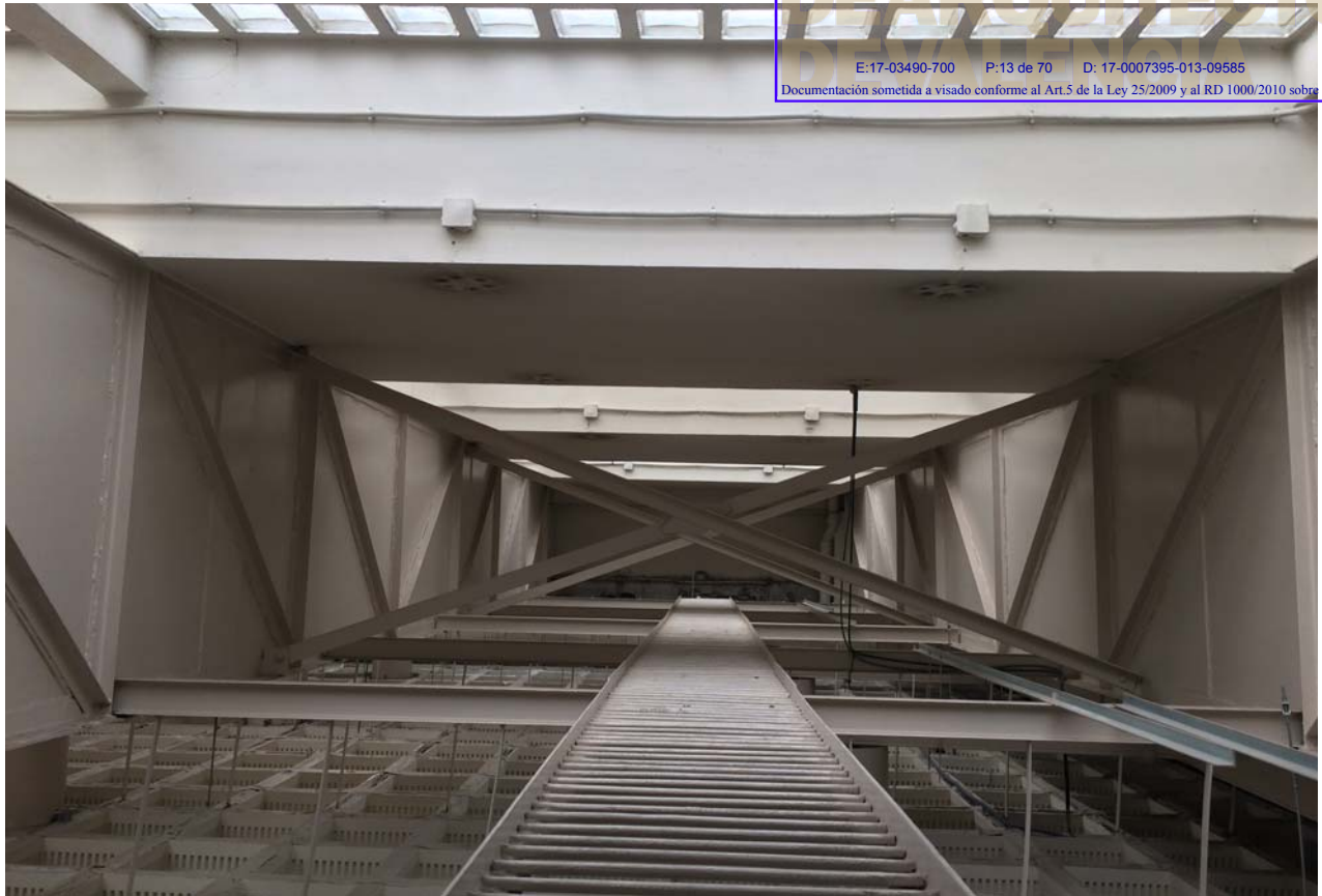
Arriba: zona instalaciones entre retícula escayola y forjado. Pasarelas de mantenimiento a mejorar su accesibilidad y seguridad con barandillas de protección.
