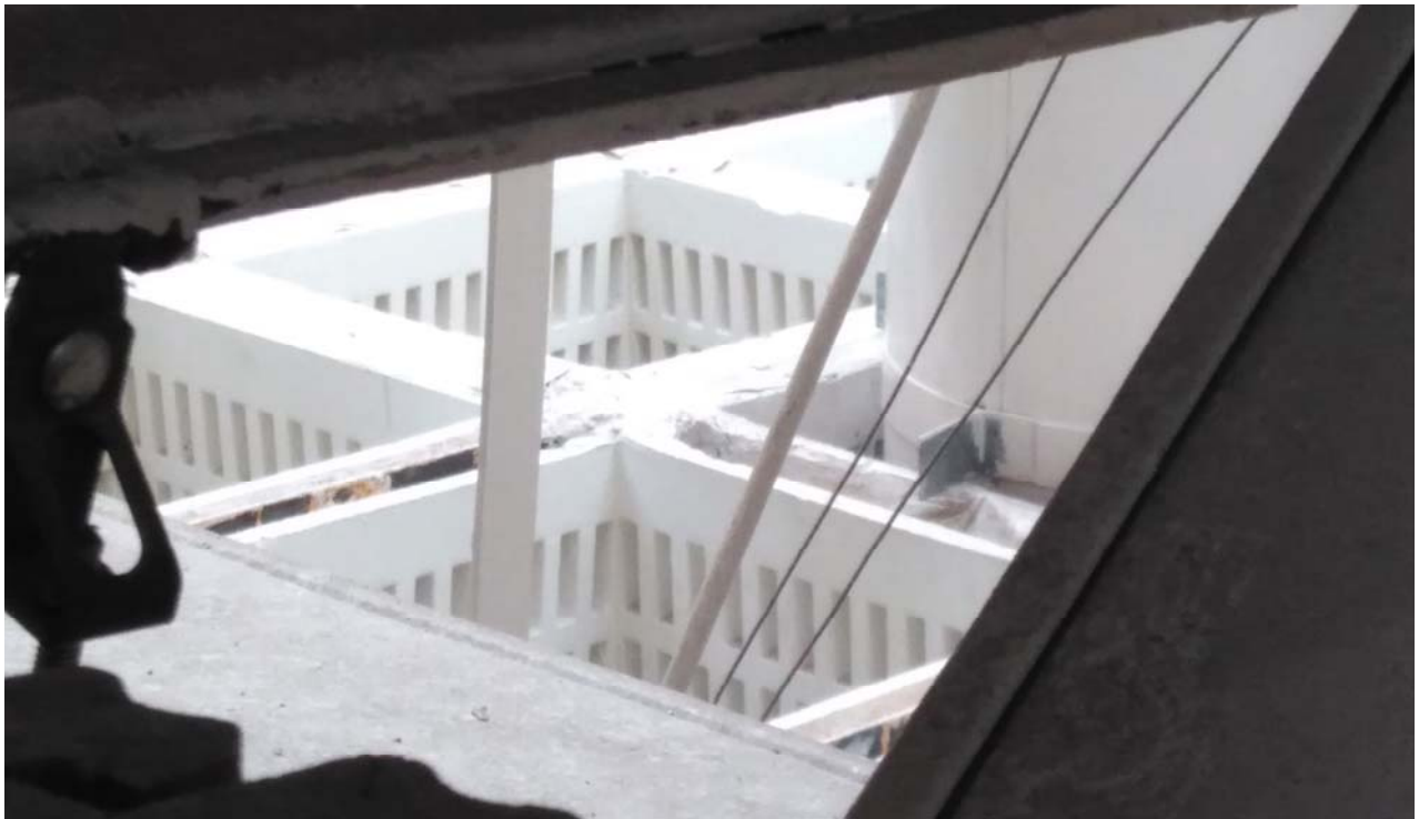
Arriba: Paso y apoyo de conducto clima en retícula escayola (conducto impulsión con rotacional).
