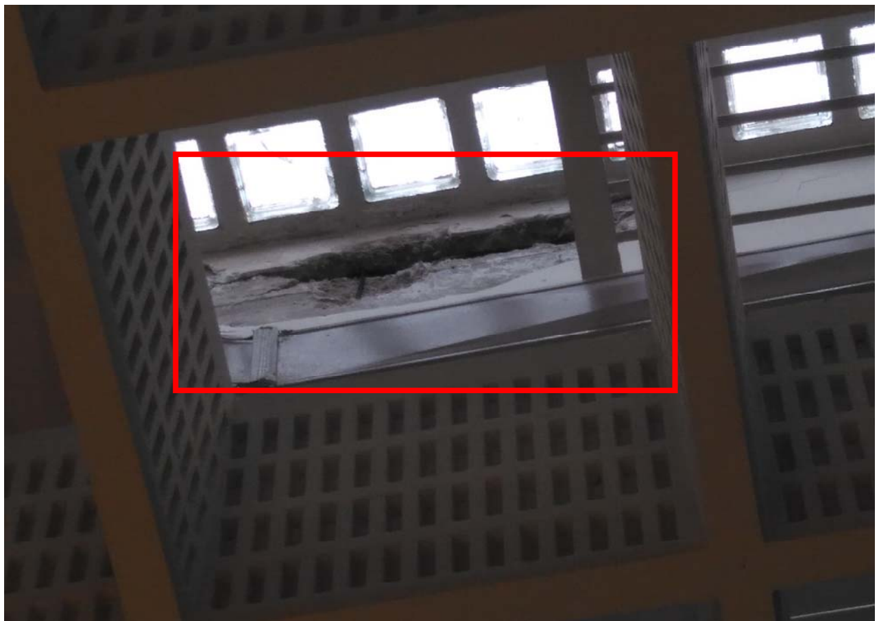
Arriba y abajo: corrosión de armaduras con desprendimiento de hormigón
