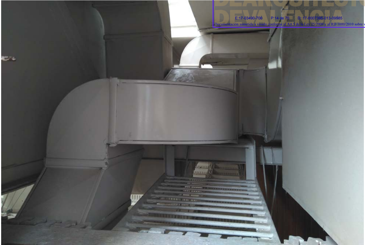
Arriba: Zona ocupada por conductos de climatización. Se muestra imposibilidad de montaje de barandillas.
