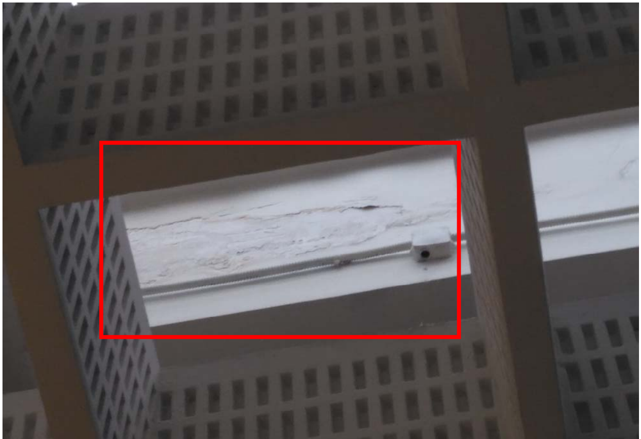
Arriba y abajo: humedad en frente de forjado sin desprendimiento
