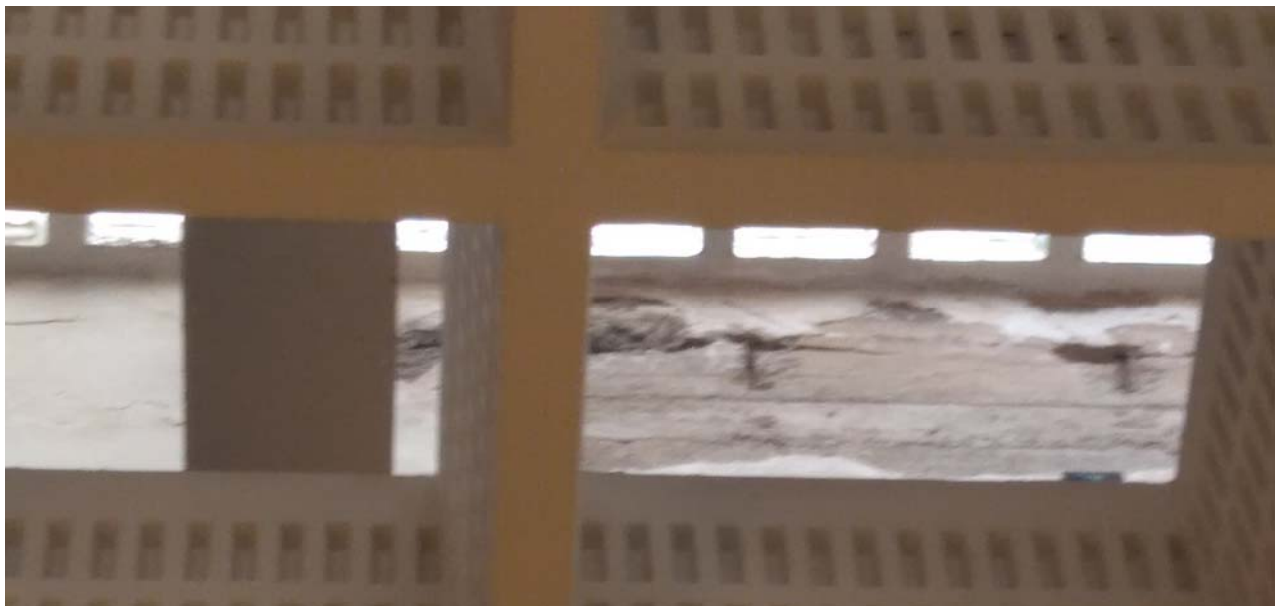
Arriba : corrosión de armaduras con desprendimiento de hormigón
