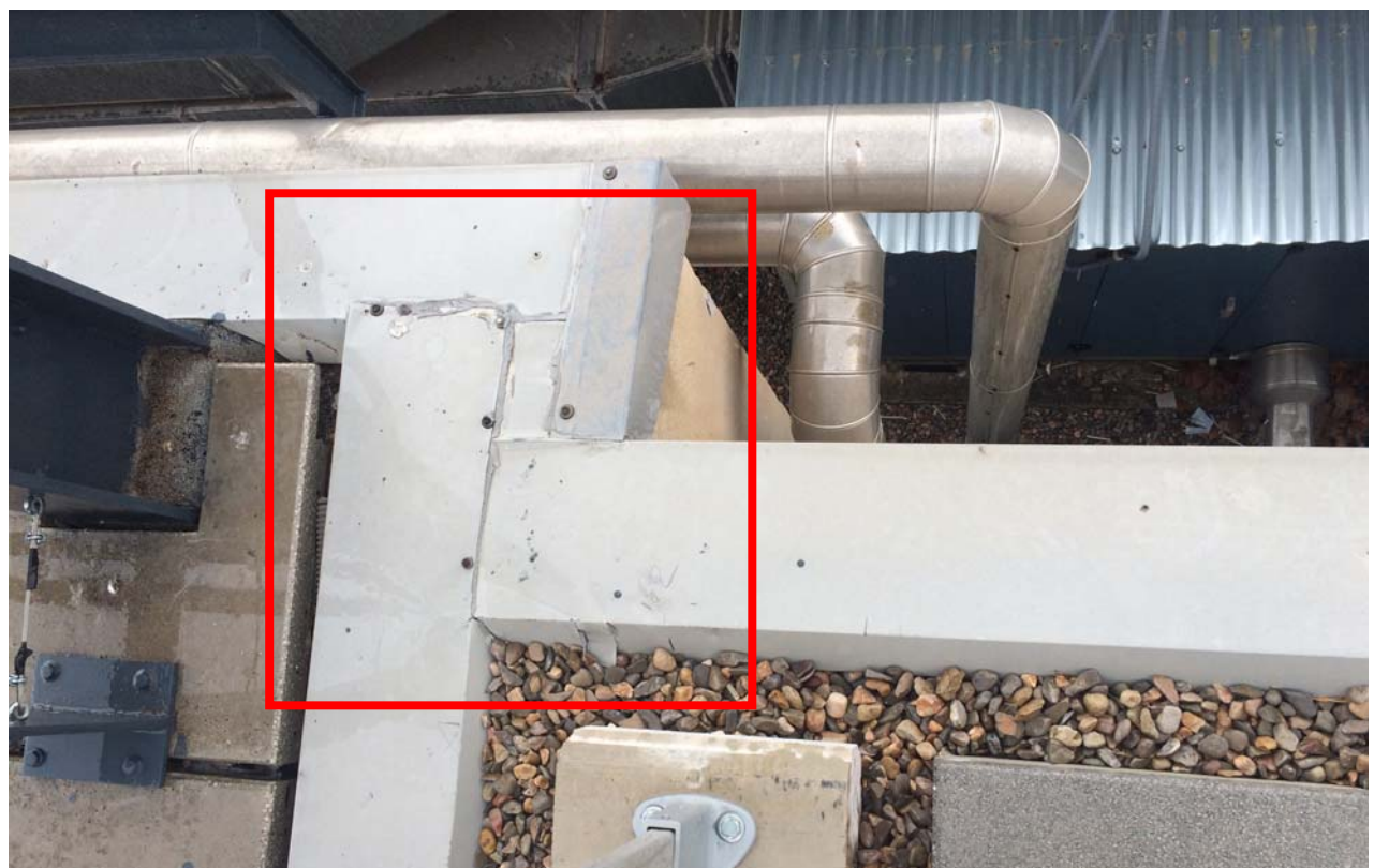
Arriba: Zonas de encuentros en mal estado en la chapa de remate a retirar y reponer
