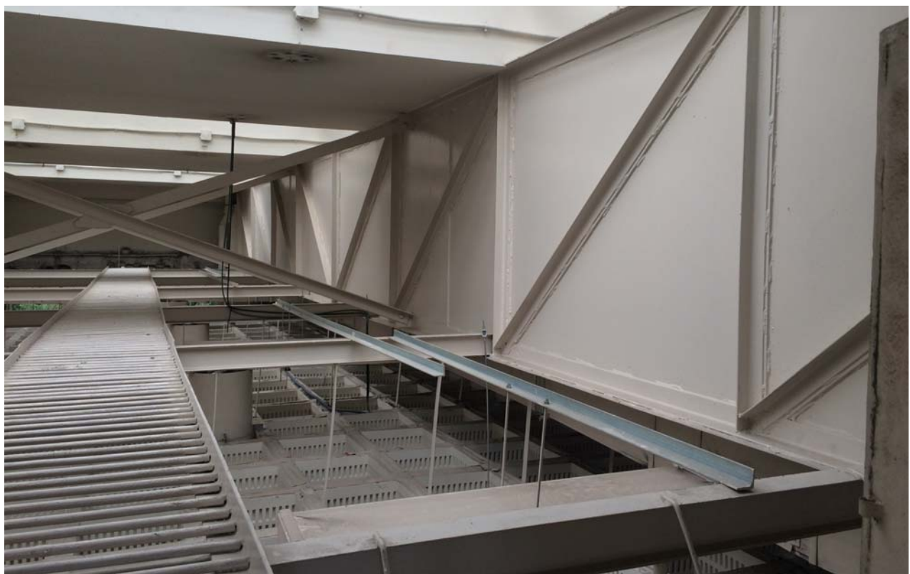
Arriba: zona instalaciones entre retícula escayola y forjado. Pasarelas de mantenimiento a mejorar su accesibilidad y seguridad con barandillas de protección.
