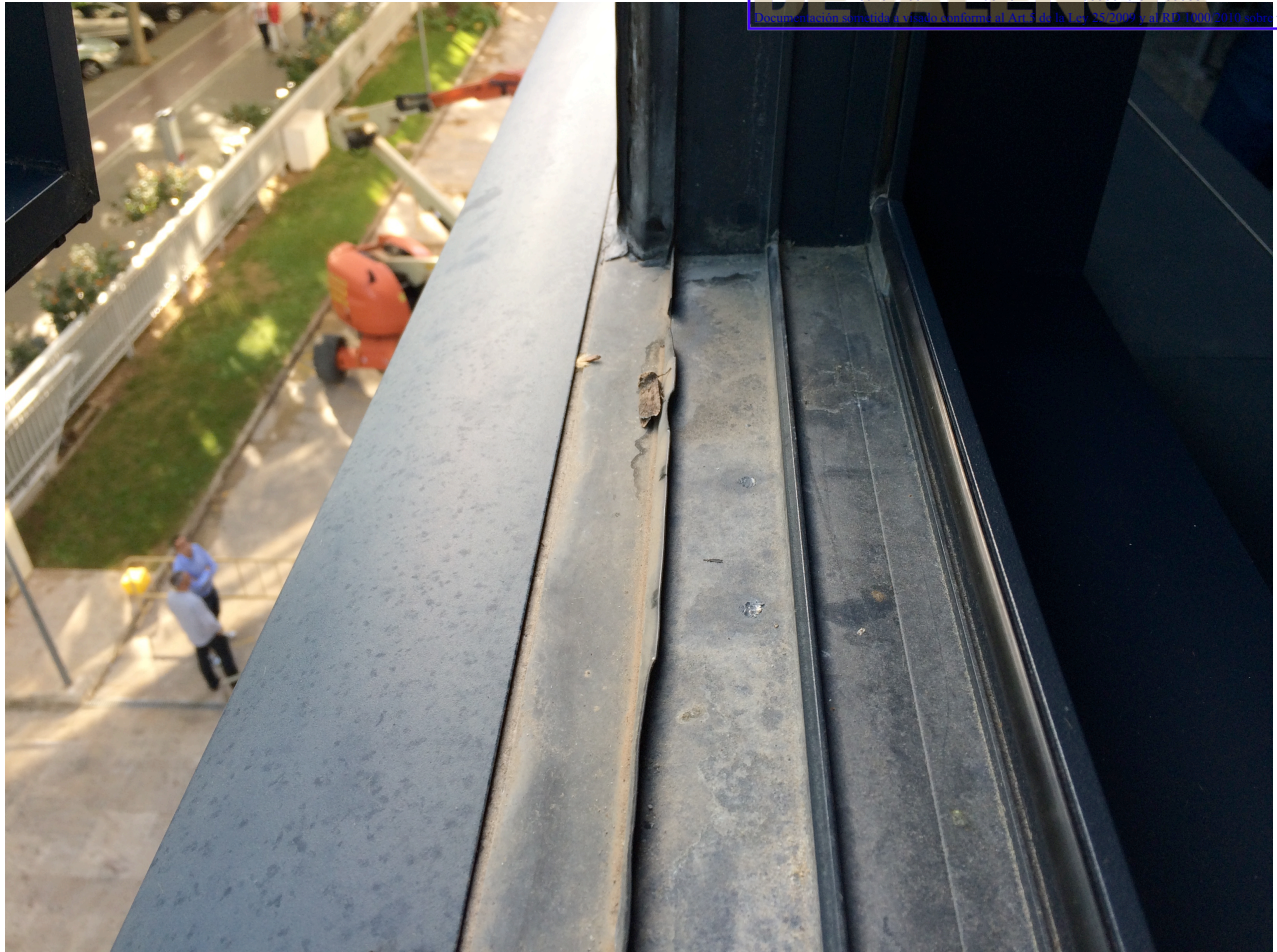
Arriba y abajo: juntas deterioradas a sustituir
