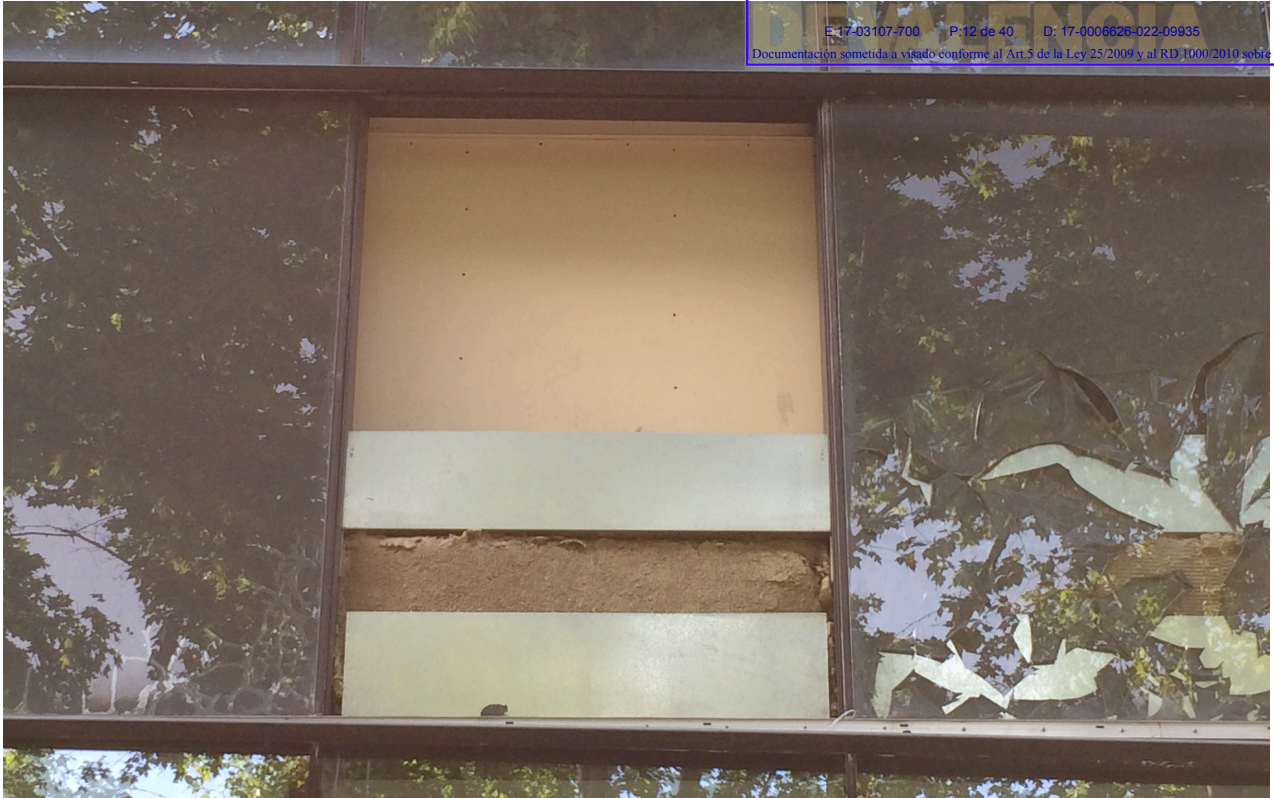
Arriba y abajo: estado del aislamiento de las zonas opacas a rehacer
