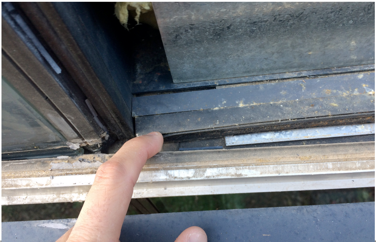
Arriba y abajo: juntas deterioradas a sustituir
