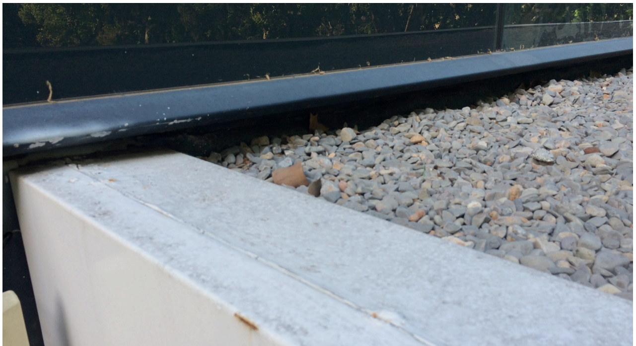
Arriba: Deterioro de tapetas de muro cortina en zona marquesina.
