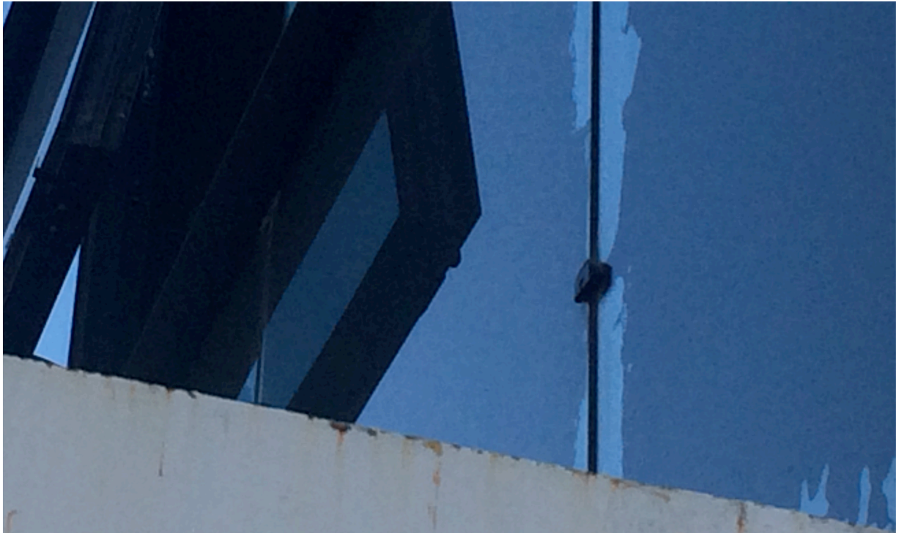
Arriba y abajo: zona deteriorada de la pintura de oscurecimiento
