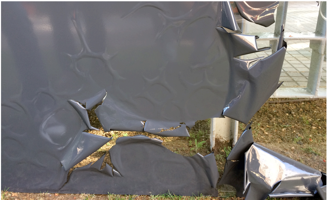
Arriba y abajo: zona deteriorada de la pintura de oscurecimiento
