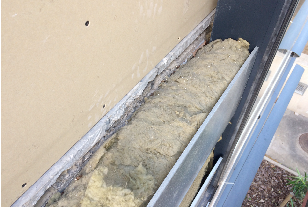
Arriba y abajo: estado del aislamiento de las zonas opacas a rehacer
