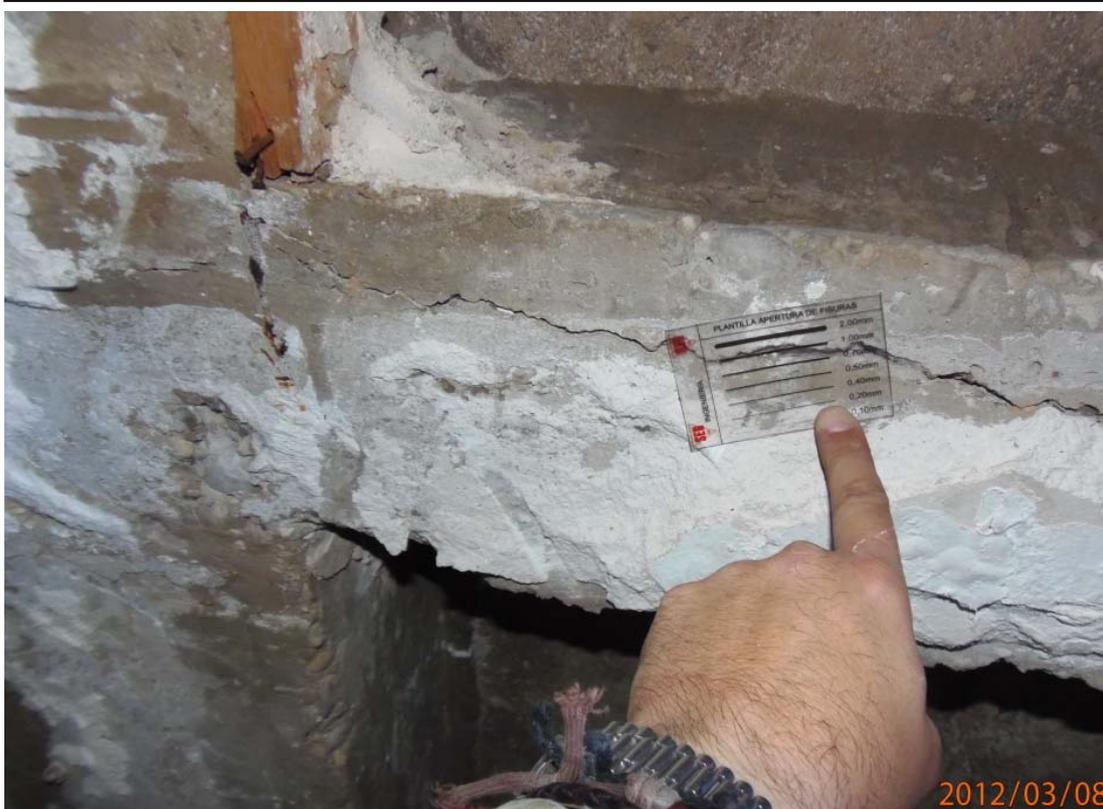
F057.- Detalle apertura fisura en vigueta, > 2mm, y fisura y armadura corroída en conexión con viga tipo 2.
