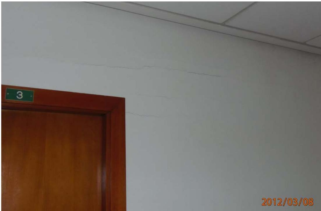
F046.- Vista general tabique pasillo junto dormitorio 3, 1ª planta, fisura horizontal tipo arco descarga por exceso de flexión del forjado.
