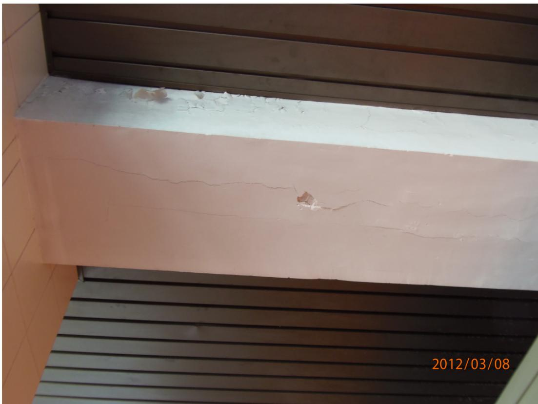
F066.- Detalle fisuras horizontales en toda la cara inferior por corrosión
