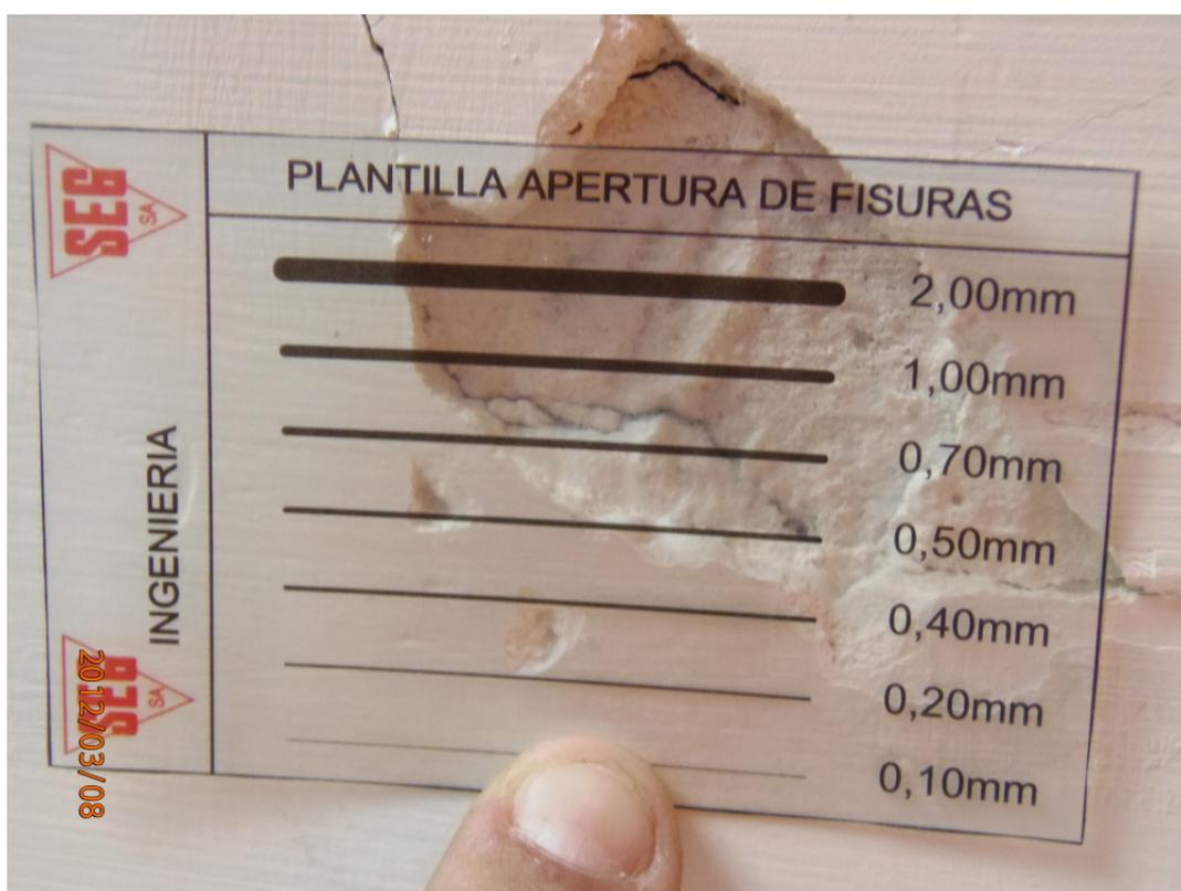
F067.- Detalle apertura fisuras entre 0.5 mm. y 0.7 mm.
