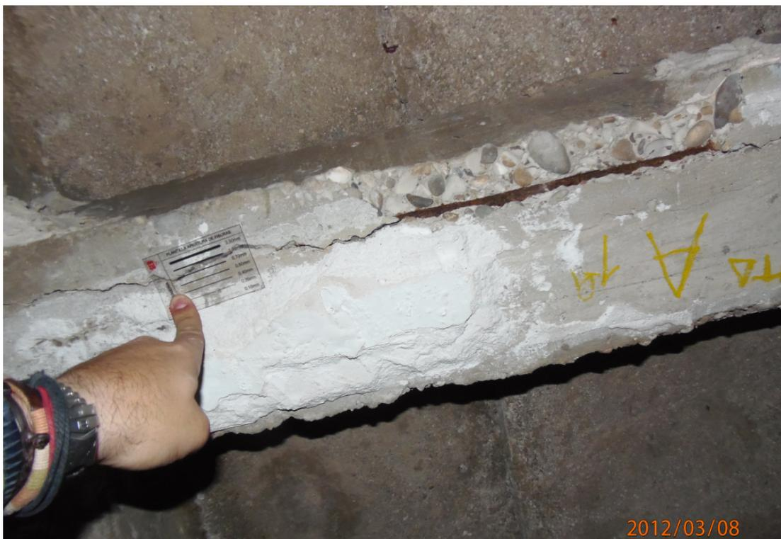
F056.- Detalle vigueta con desprendimientos de recubrimiento y fisuras por corrosión de armadura inferior.
