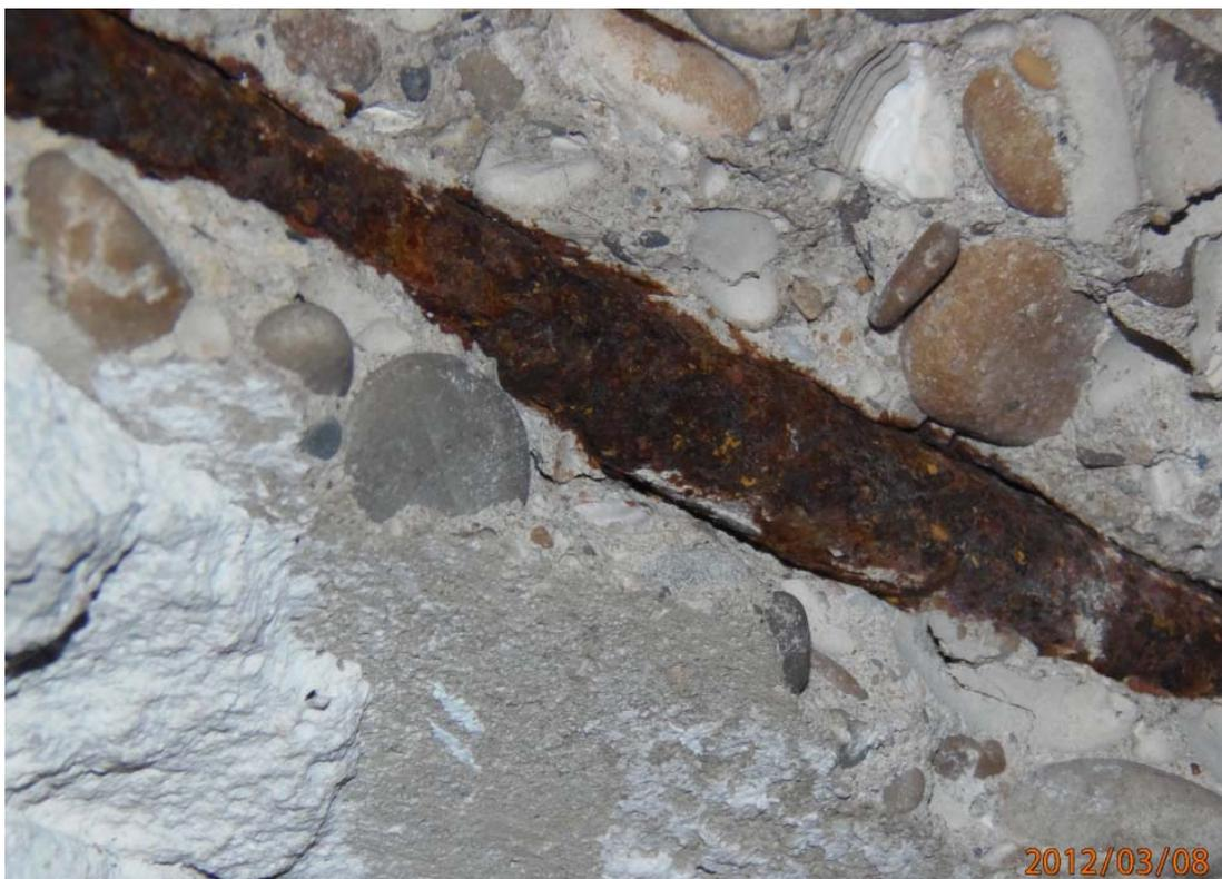
F058.- Detalle de corrosión avanzada en armadura inferior de vigueta, y restos de conchas marinas en hormigón.
