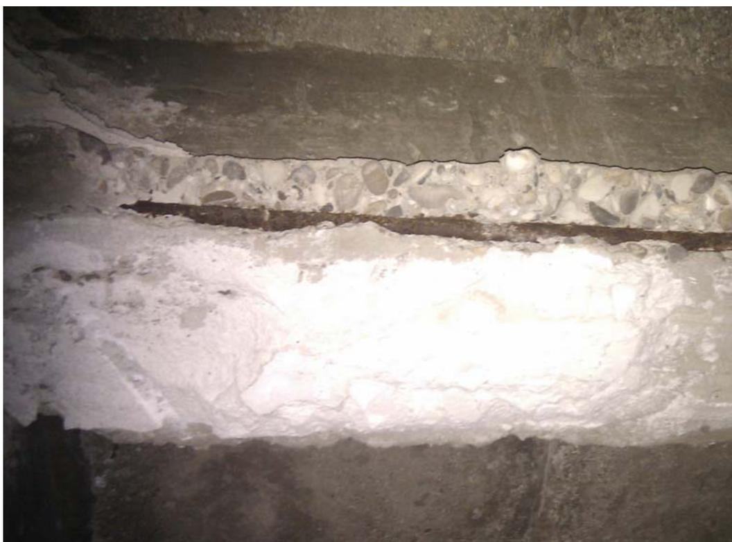
F073.- Detalle vigueta tras la extracción de la muestra, armadura inferior vigueta con corrosión avanzada.
