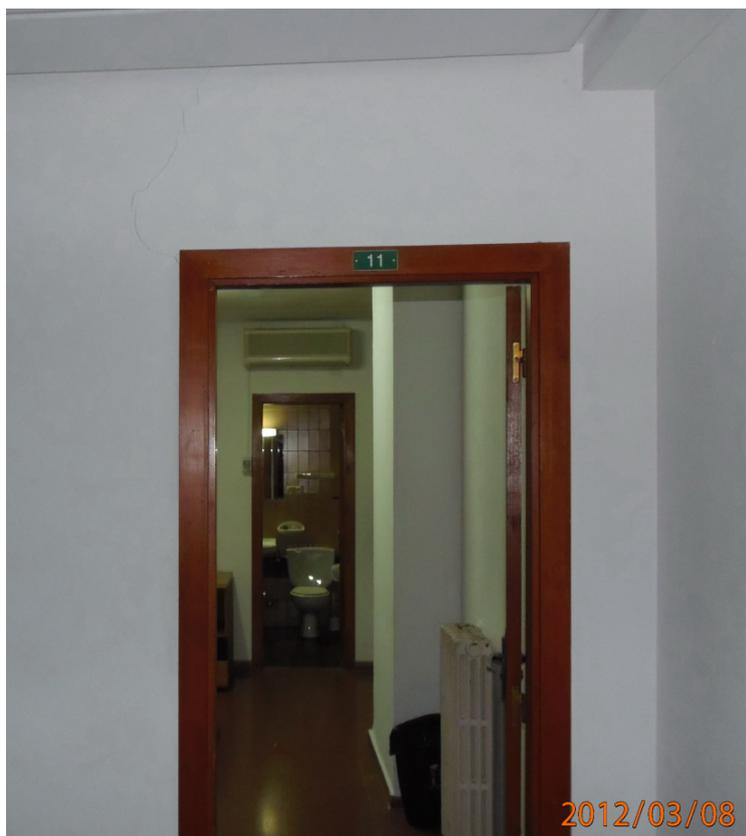
F041.- Vista general acceso dormitorio 11, 1ª planta, con fisura tipo arco descarga por exceso flexión del forjado, fisura reparada y vuelta abrir.
