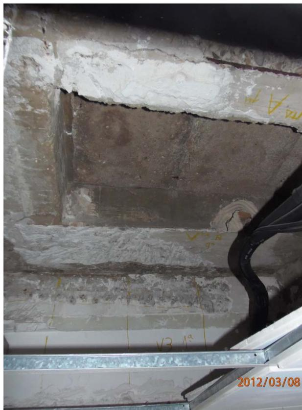
F055.- Detalle viga tipo 1, tipo 2 y vigueta.
