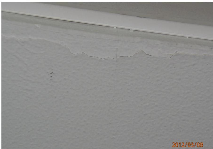
F053.- Detalle fisura horizontal en viga por oxidación armadura.
