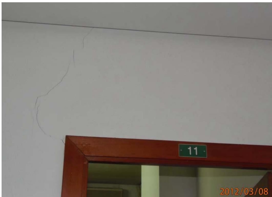
F042.- Detalle acceso dormitorio 11, 1ª planta, con fisura tipo arco descarga por exceso flexión del forjado, fisura reparada y vuelta abrir.
