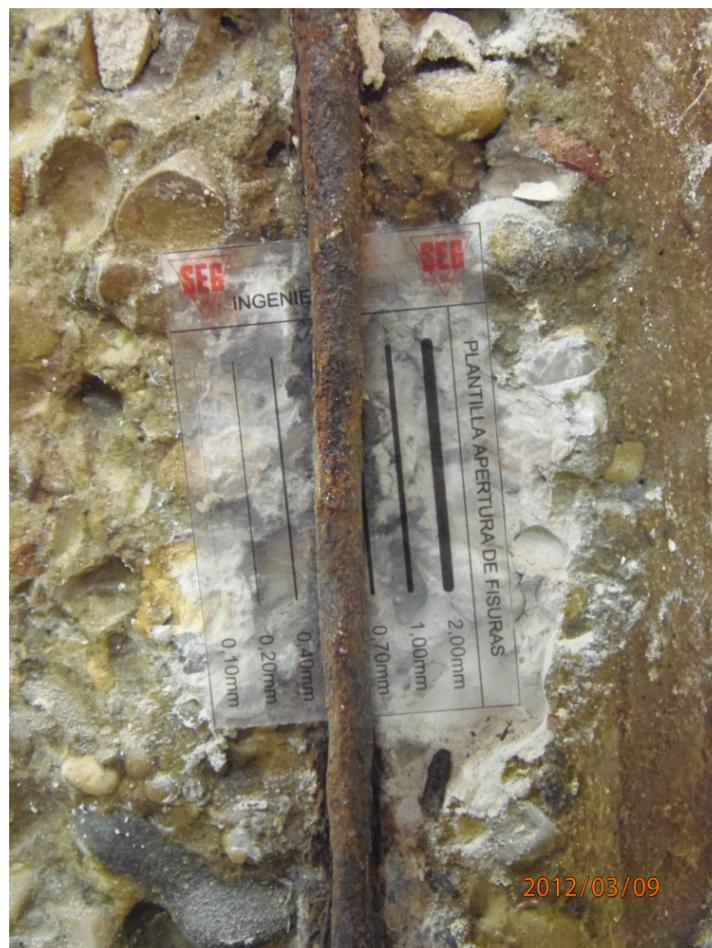
F071.- Detalle sección residual de la armadura tras la pérdida de sección por corrosión, diámetro residual 5 mm.
