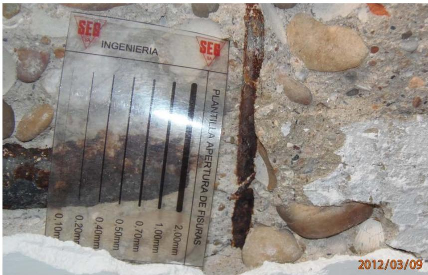
F075.- Detalle corrosión armadura inferior y cercos, probable ataque de cloruros.
