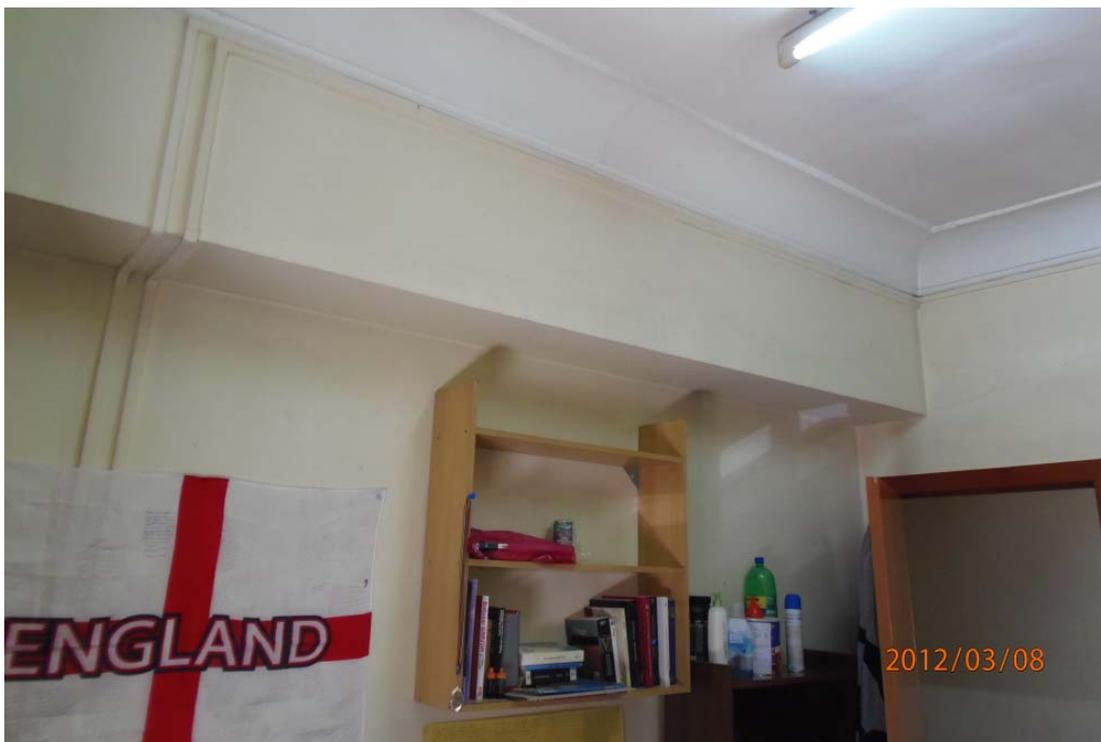
F064.- Detalle viga con dos fisuras inclinadas por fallo a cortante y fisura en tabique transversal a viga por exceso flexión.
