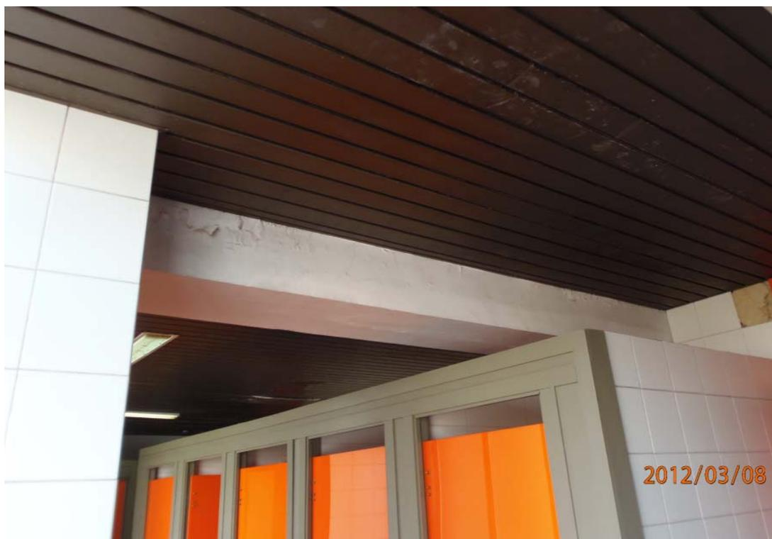
F065.- Vista general viga T-1, 2ª planta, duchas frente dormitorio 5 con dos fisuras horizontales en toda la cara inferior por corrosión armadura.
