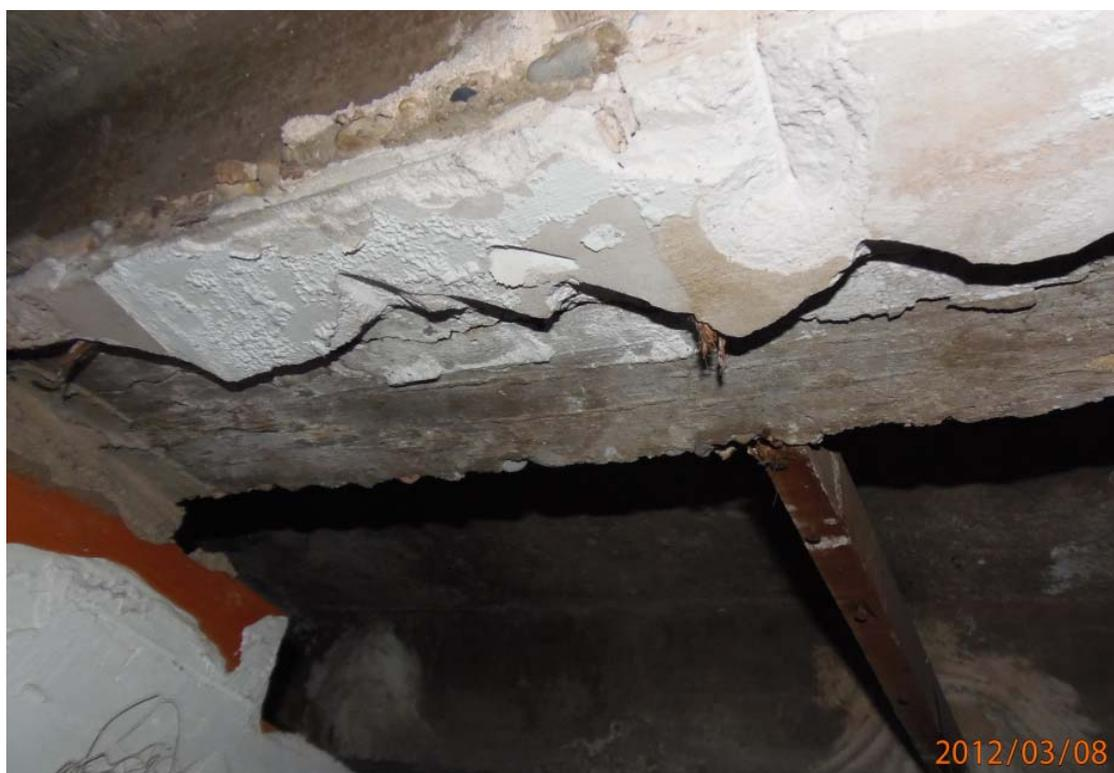
F059.- Viguetas contiguas con fisuras en cara inferior con apertura > 1mm.
