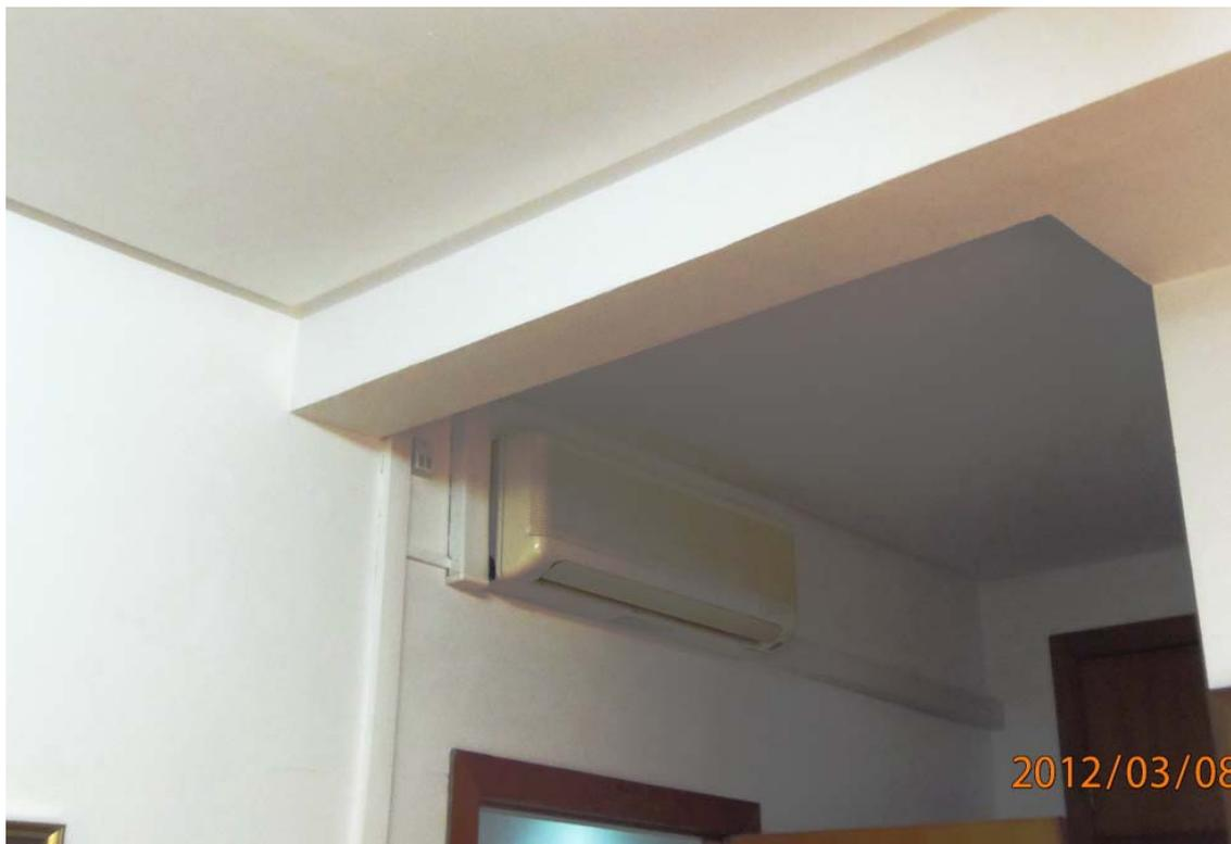
F049.- Vista general viga habitación 7, tabique con fisura horizontal tipo arco de descarga por exceso de flexión del forjado.
