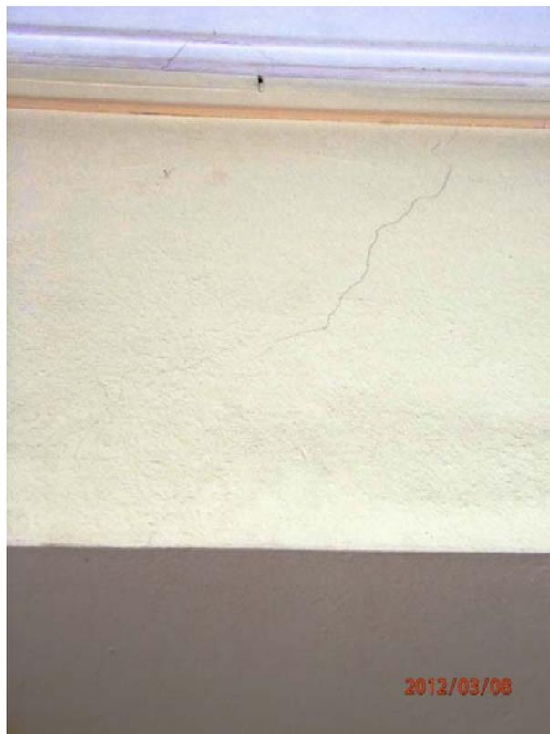
F063.- Detalle fisuras inclinadas por fallo a cortante.
