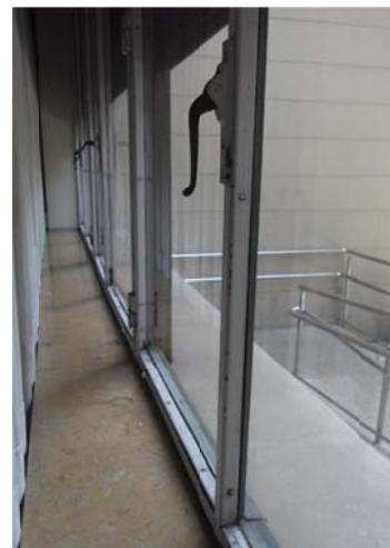
**Fotos nº 4-6:** Detalles de tipología y estado de conservación de la carpintería de fachada.
