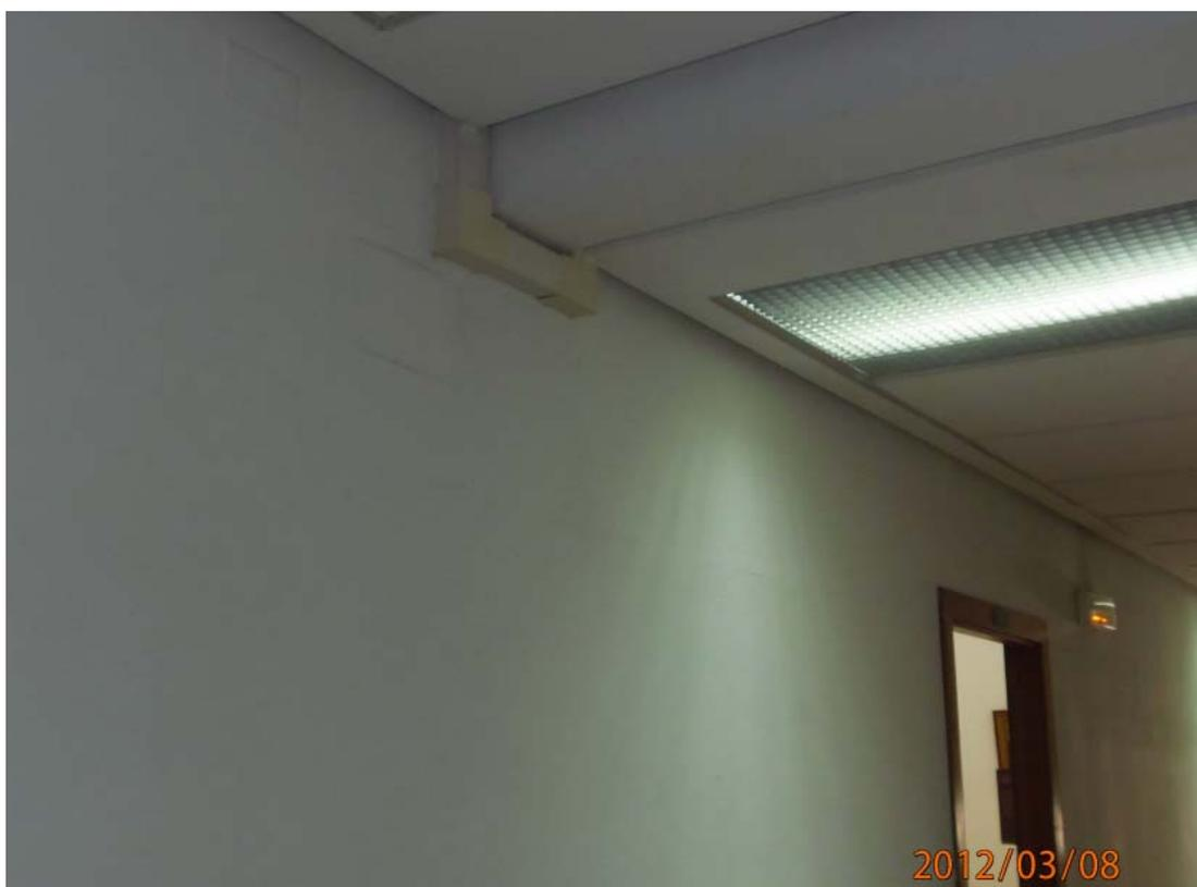
F048.- Cuelgue de viga tipo 1, entre dormitorio 5 y 10, y tabique con fisura horizontal tipo arco de descarga por exceso de flexion del forjado, reparada y vuelta abrir.
