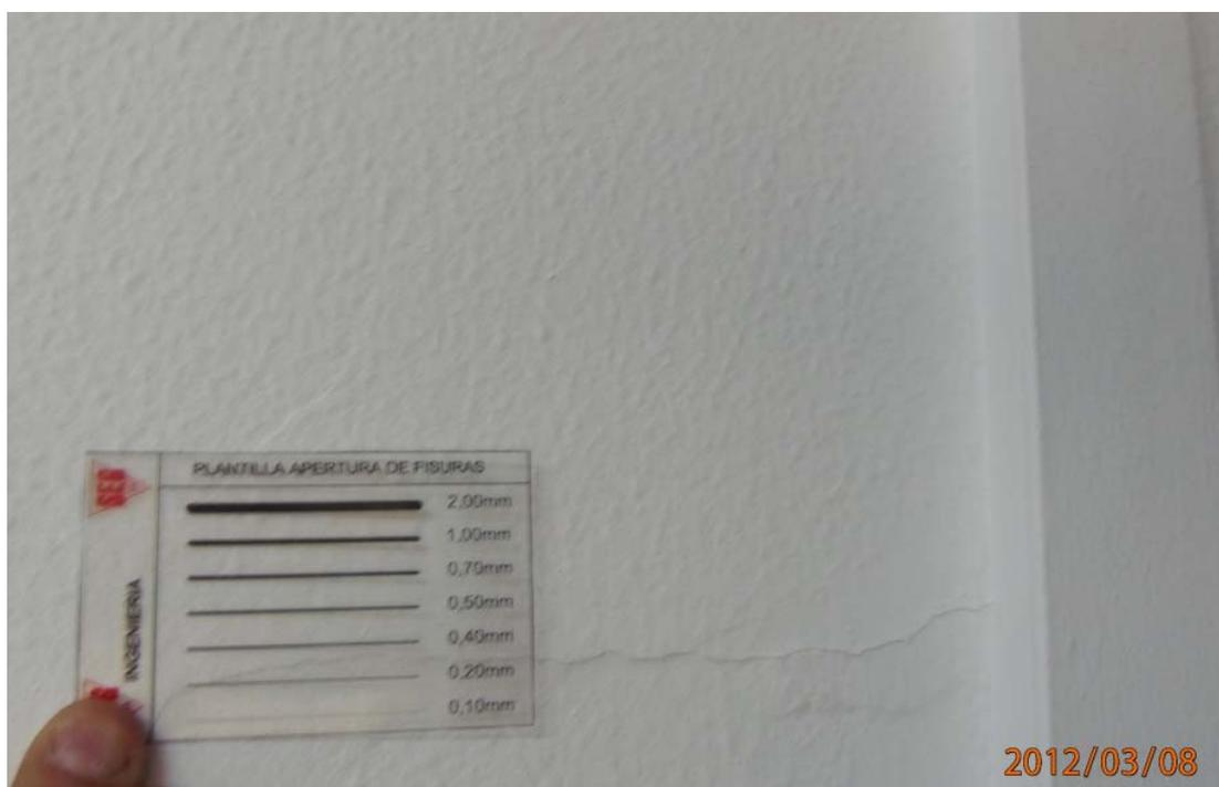
F050.- Detalle fisura horizontal en tabique tipo arco de descarga por exceso de flexión del forjado, reparada y vuelta abrir, apertura actual 0.2 mm.
