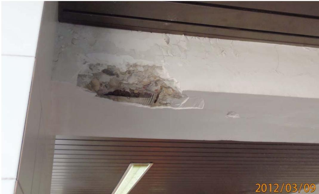
F074.- Vista general zona de extracción muestra M-3 de viga, forjado 3ª planta, techo 2ª planta, zona duchas frente dormitorios 224.
