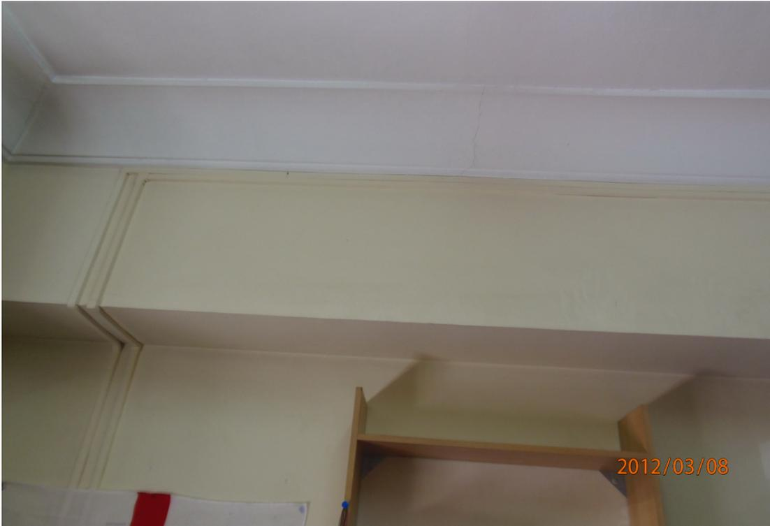
F062.- Detalle viga T-1, pasillo 2ª planta, dormitorio 252 con dos fisuras inclinadas por fallo a cortante.
