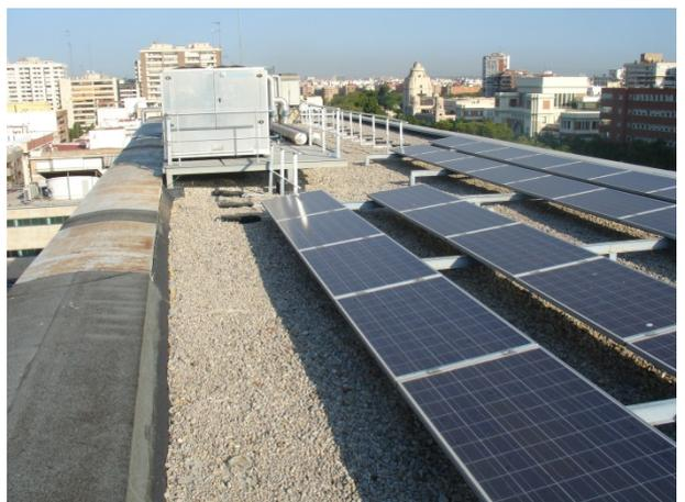
Ausencia de protecciones en cubierta y antepechos con altura insuficiente
