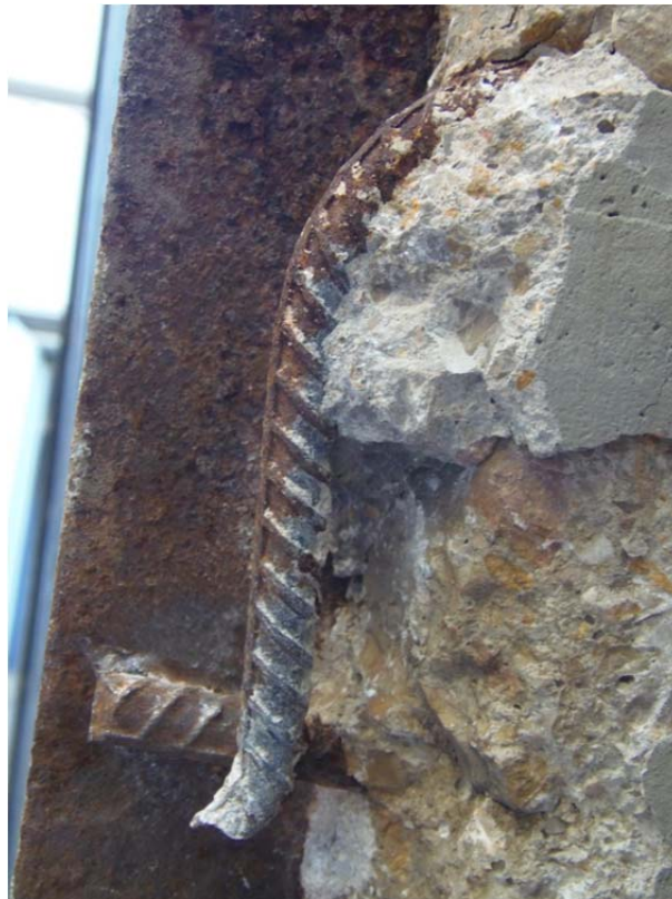
Armado de losa y anclaje de la losa con el angular
