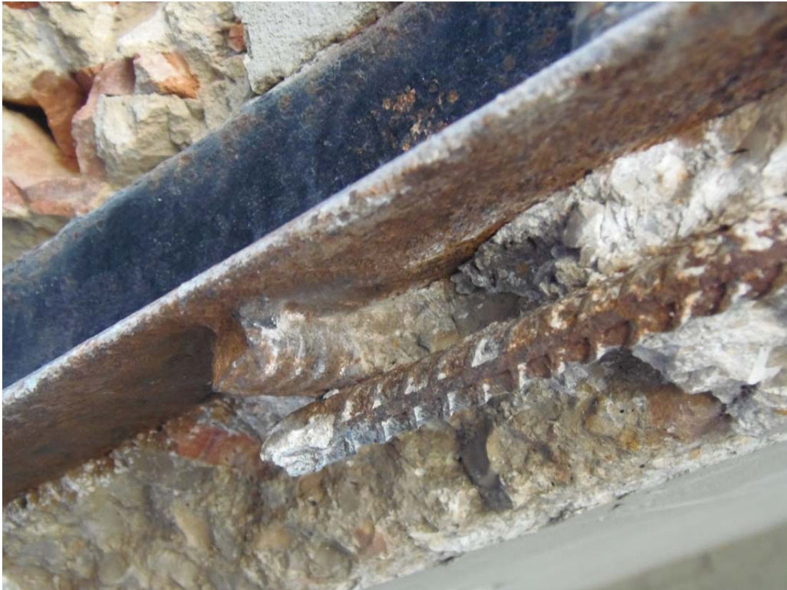
Armado de losa y anclaje de la losa con el angular
