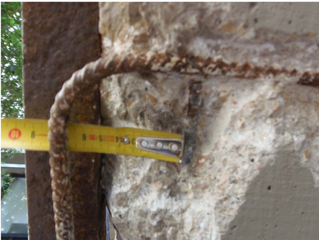
Medición del recubrimiento de la losa
