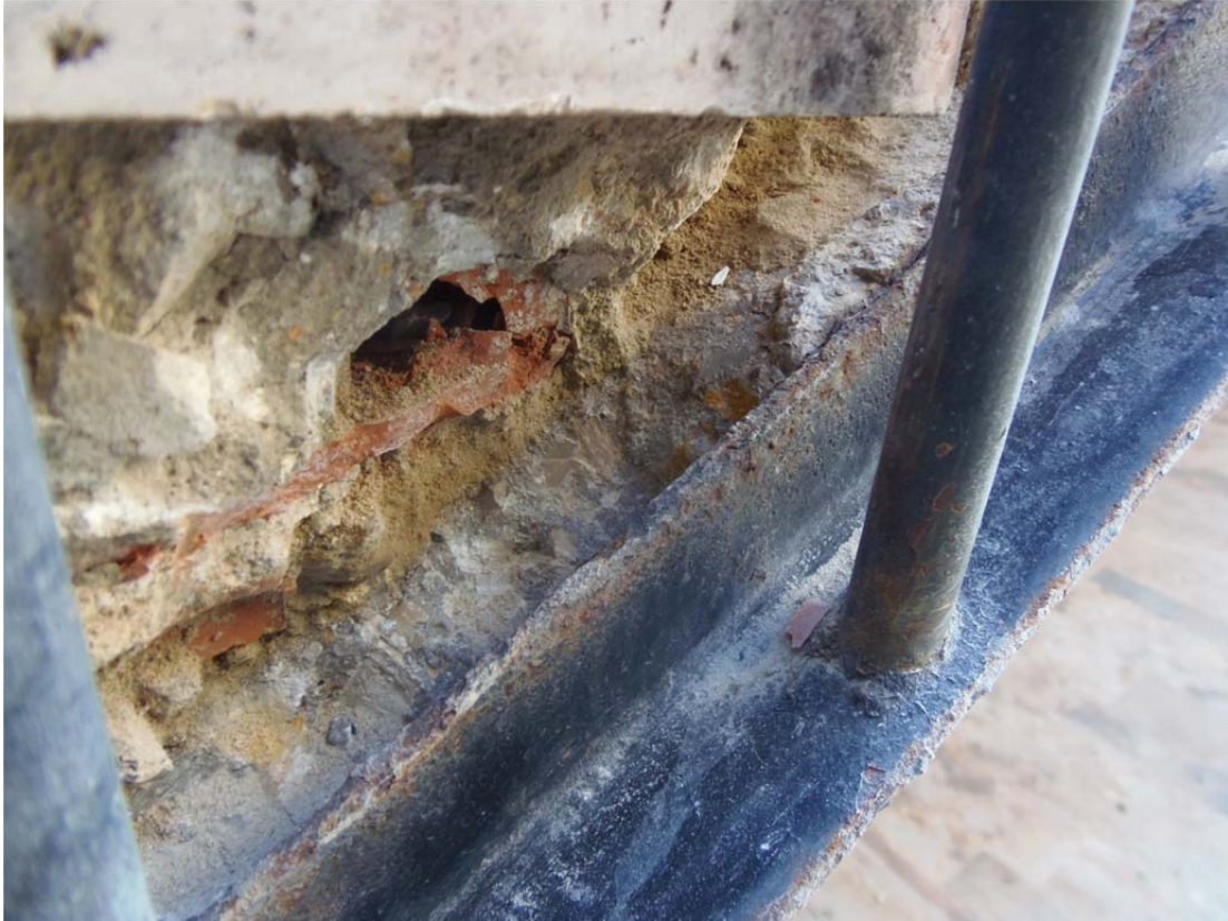
Estado de conservación del angular
