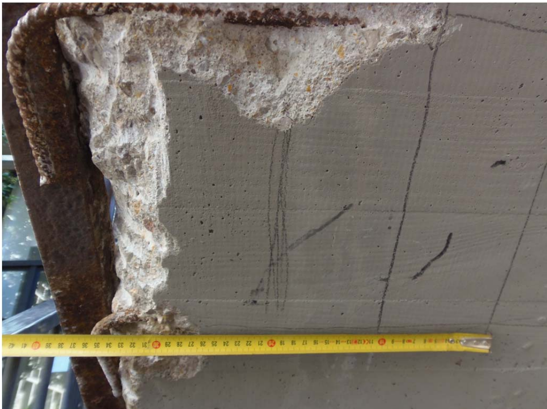
Localización mediante pachometría del armado de la losa
