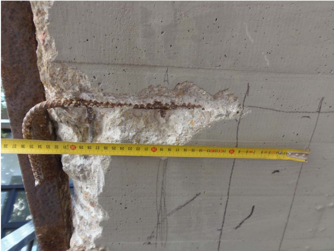
Vista del armado de la losa
