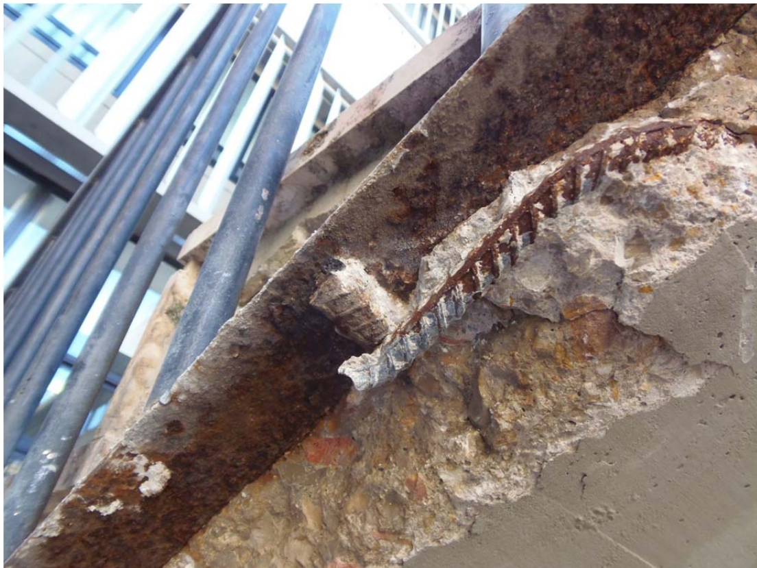
Armado de la losa de escalera
