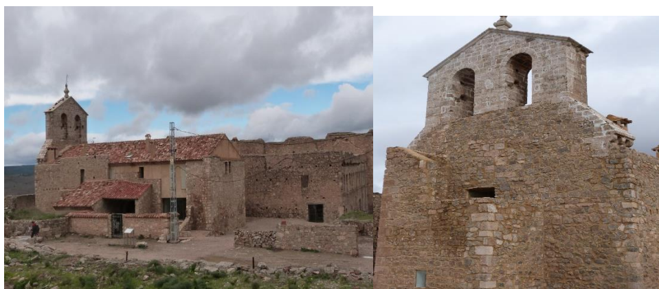
6ª Al·legació, Element patrimonial afecta per les noves construccions en el projecte.
