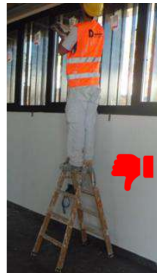
No trabajar sobre los últimos peldaños
