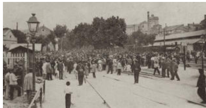
imatge de les vies i les andanes de l'antiga estació de ferrocarril, al fons. levante-emv
