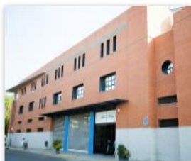
Piscina coberta Burjassot - Exterior
