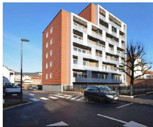
Imatge 16. Edifici amb estructura de palla de 7 plantes. Font: Okambuva.
