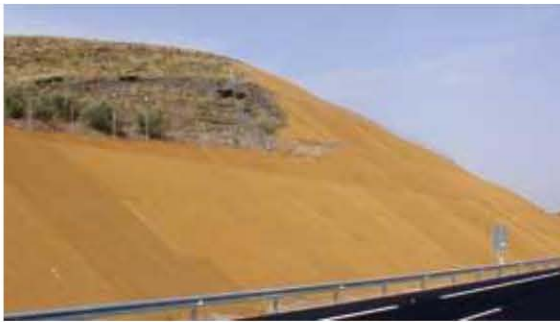
Imatge 7. Exemple d'aplicació de mantes de palla a una vessant de carretera. Font: https://ingenieriaysterrestauracionambiental.wordpress.com/page/11/
