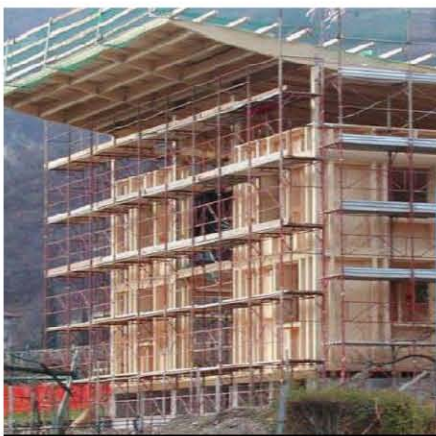
Imatge 15. Edifici amb estructura de palla de 3 pisos. Font: Okambuva
