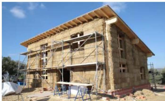
Imatge 18. Casa unifamiliar amb l'estructura acabada. Font: Okambuva.
