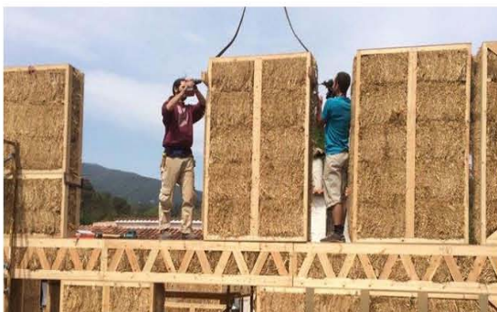
Imatge 17. Personal d'Okambuva construint una casa amb bales de palla. Font: Okambuva.
