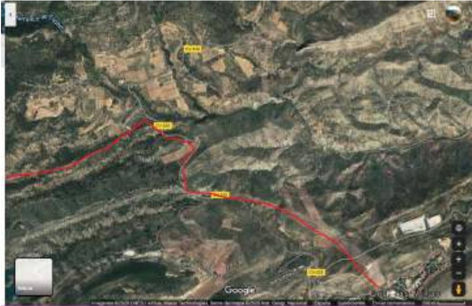
Tramo 2 líneas de alta tensión [Ilustración 40]. Recuperado de: Google Earth. https://www.google.es/intl/es/earth/index.html
