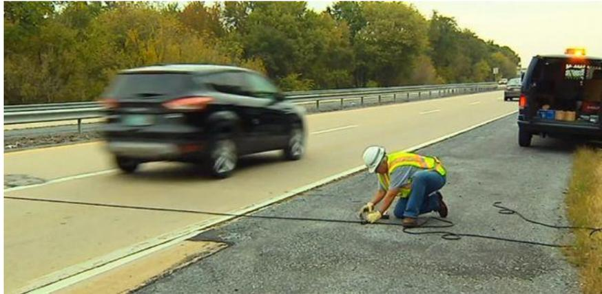
*Figura 1 - Instalación de tubos neumáticos para el análisis del tráfico.
