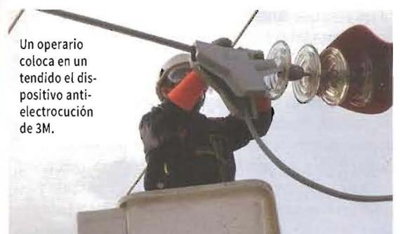
Un operario coloca en un tendido el dispositivo anti-electrocución de 3M.
