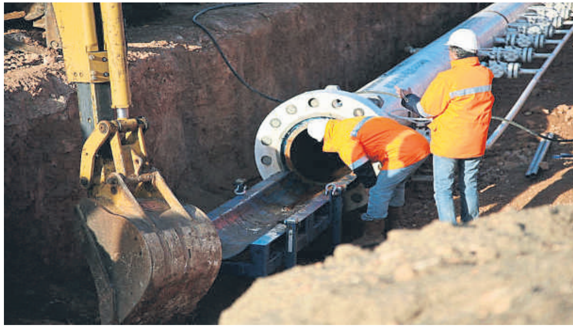
Gasoducto en pruebas
